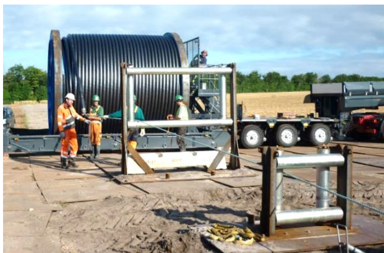
Figur 2-16 Kabeltromle på blokvogn
