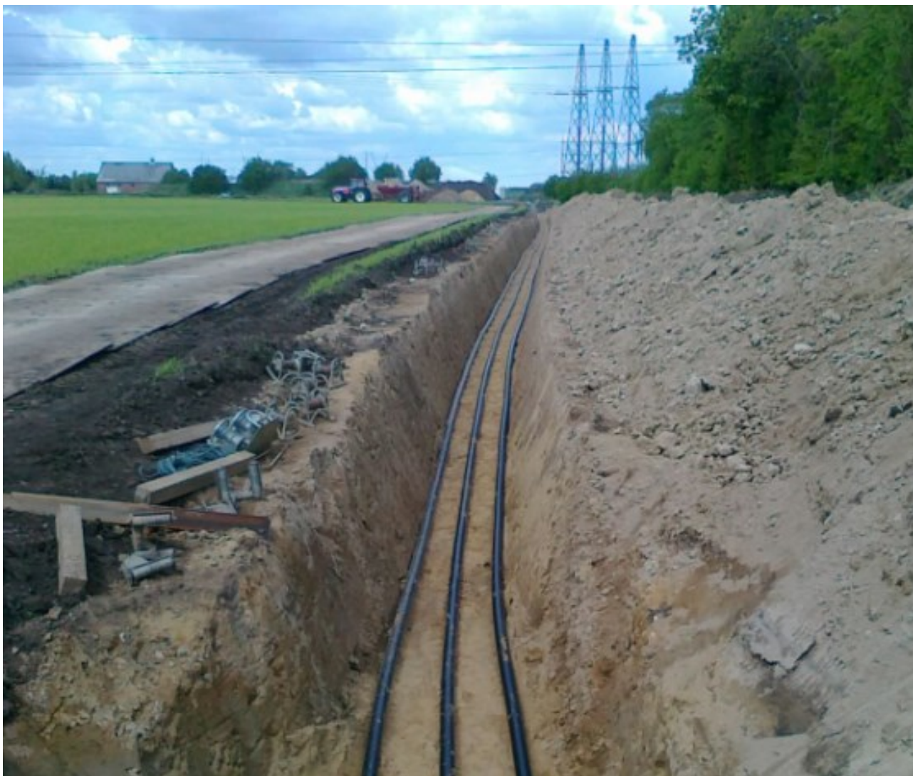
Figur 2-7 Kabelanlæg lagt ud i åben grav
