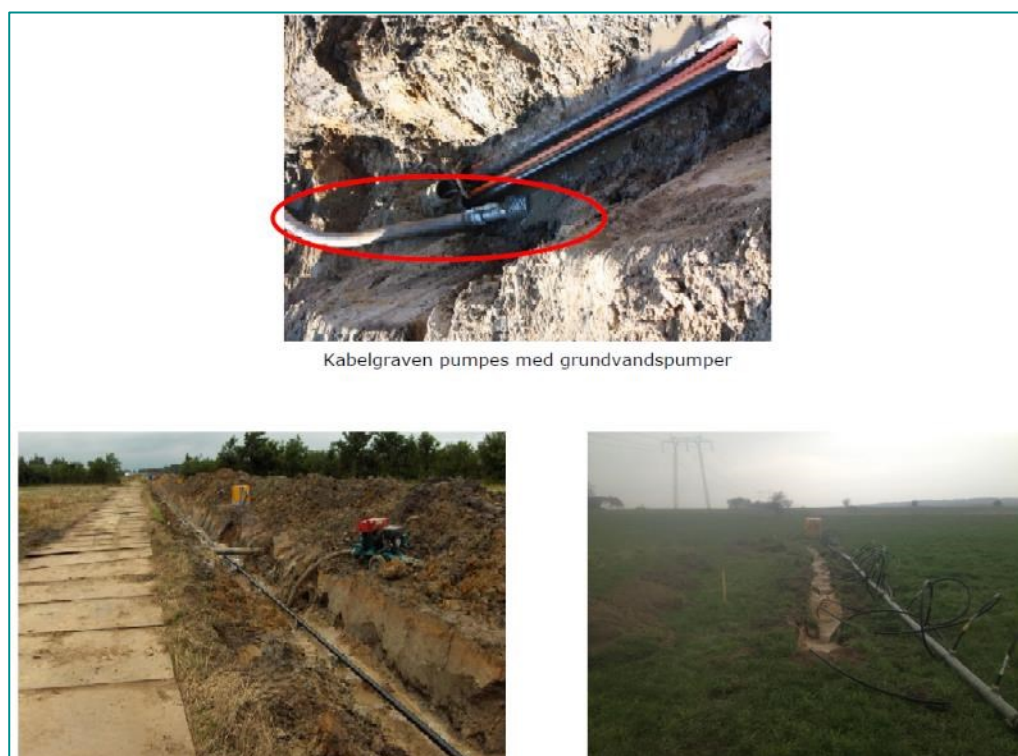
Figur 2-9 Forskellig metoder til at holde kabelgraven tør. På billedet til venstre etableres drænrør, til højre etableres su- gespidsanlæg
