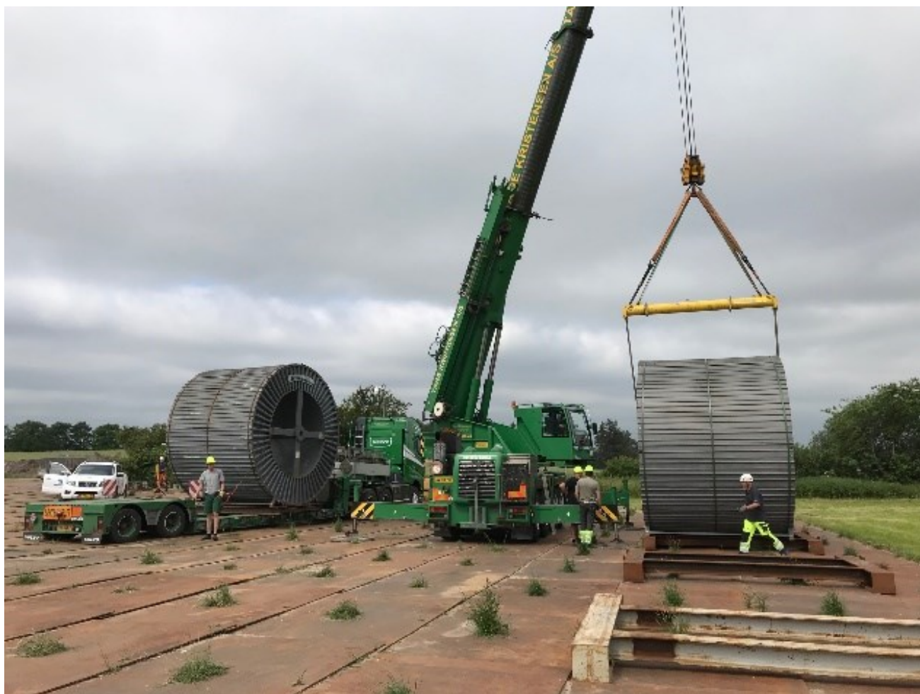
Figur 2-10 Håndtering af kabeltromler på tromleplads
