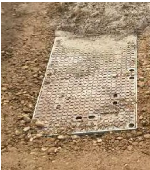
Figur 2-3 Eksempel på fiberbrønd i terræn
