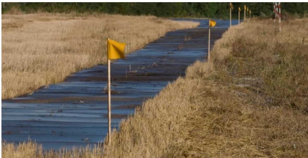
Figur 2-12 adgangsvvej med køreplader
