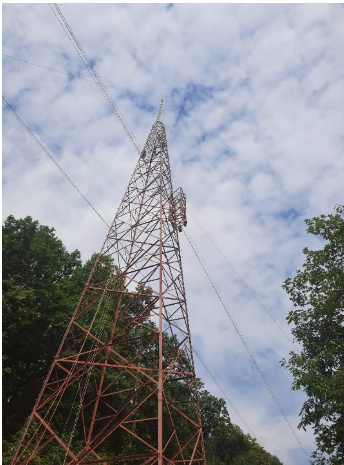
Figur 6-3. Derrick i brug ved demontering af mast.
