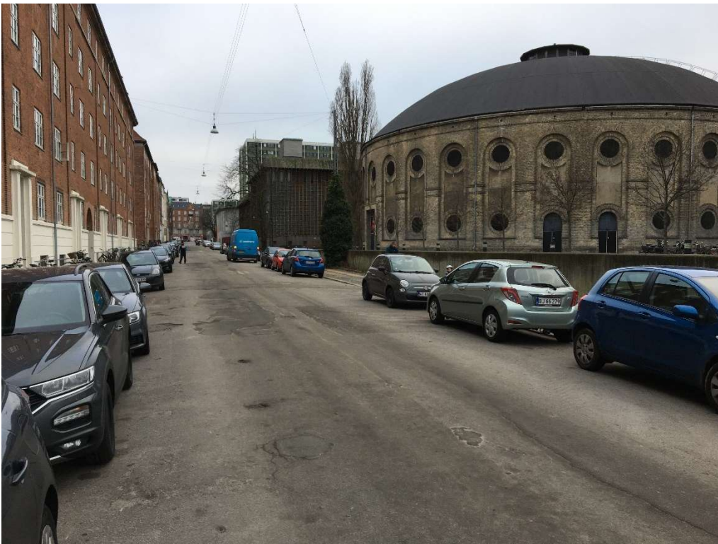
Nyborggade med Østre Gasværk forest og Svanemølle Koblingsstation bagved.
