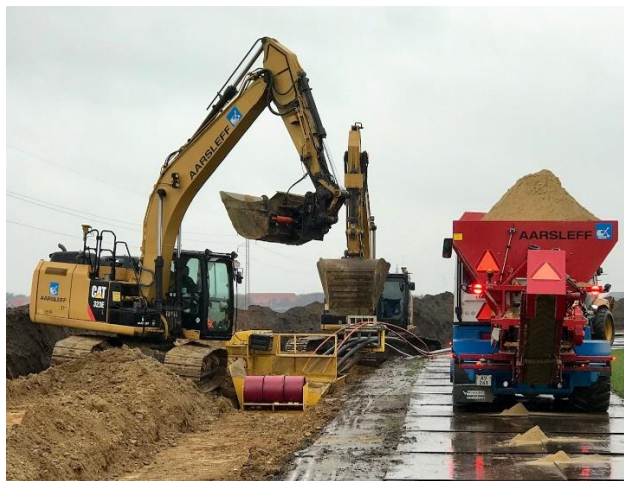
Nedlægning af 150 kV-kabler i flad forlægning ved hjælp af gravekasse
