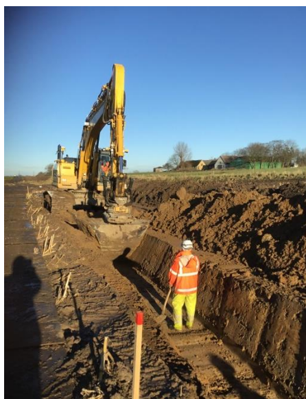
Opgravning af kabelrende til åben grav.
