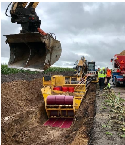
Nedlægning af 150 kV-kabler i flad forlægning ved hjælp af gravekasse
