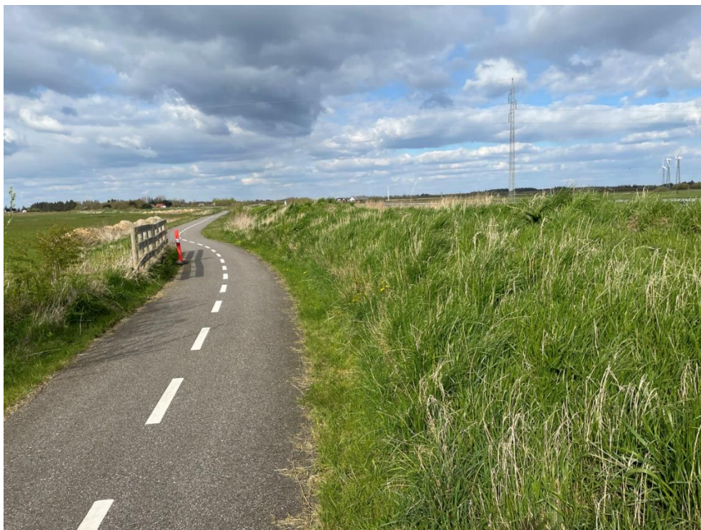
Figur 3-2 Diget ses til højre i billedet som det fremstod i slutningen af april måned.
