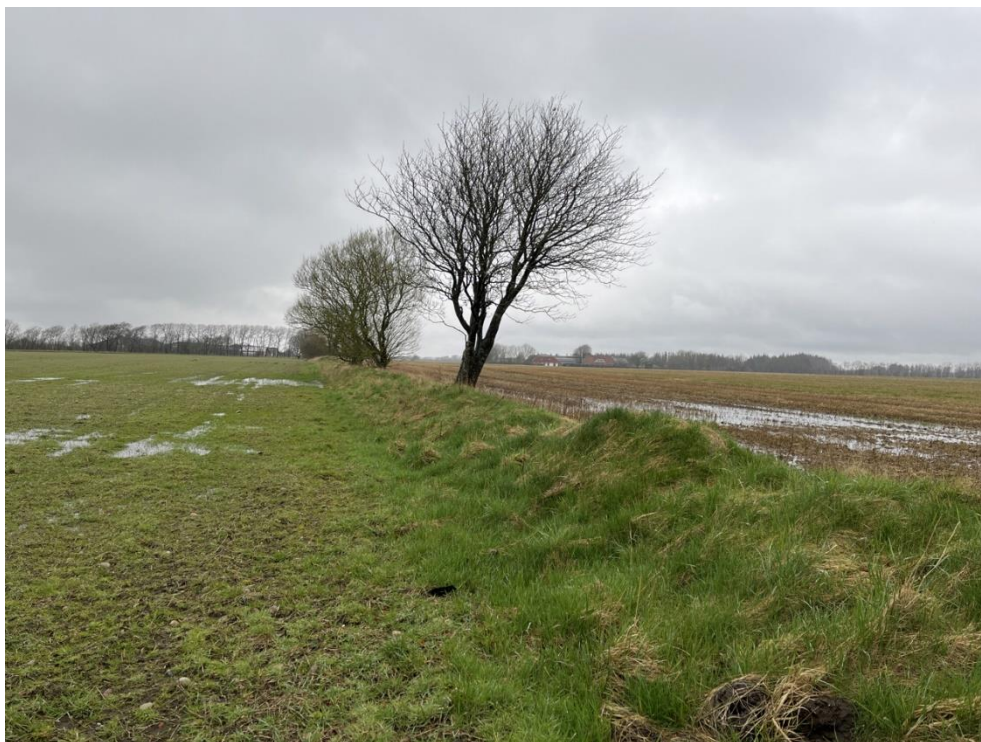
Figur 3-3 Diget ses til højre i billedet som det fremstod i starten af april måned.
