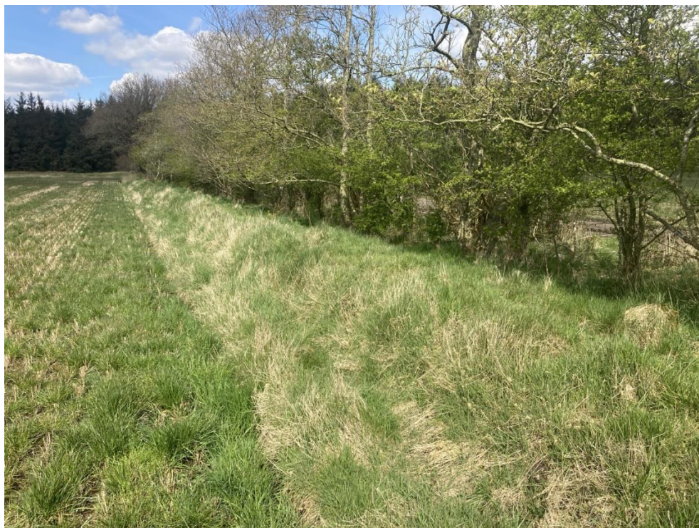
Figur 3-7 Diget ses til højre i billedet som det fremstod i slutningen af april måned.
