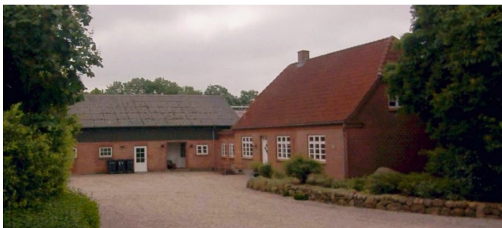
Figur 3-15 Kassøvej 25 set fra nord. Hestestalden ses til venstre, og stuehuset ses til højre.
