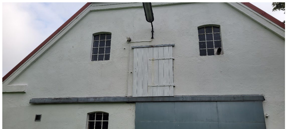
Figur 3-11 Nordlig gavl på Kassøvej 24. Generelt er bygningerne meget tætte, og den viste gavlluge vurderes at være det eneste sted, hvor små flagermus potentielt kan klemme sig ind, men der blev ikke fundet spor eller andre tegn på, at dette er tilfældet.
