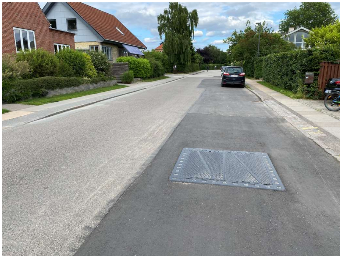
Figur 2-2: Linkboksbrønddæksel i vejareal.
