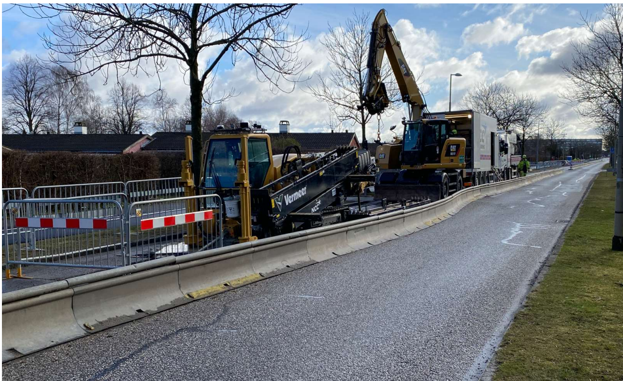
Figur 2-9: Eksempel på opstilling af maskiner ved udførelse af en underboring. Til venstre ses boremaskine med hegn opsat omkring boregruben. Bagved holder en gravemaskine til håndtering og flytning af borestænger mellem stativ og boremaskine. Bagerst ses lastbilen, hvor borevæske blandes og pumpes til boremaskinen.
