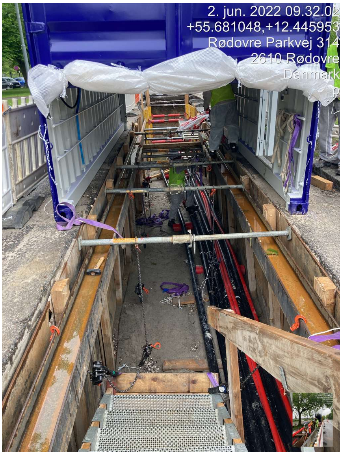
Figur 2-6: Container til at udføre muffesamlinger i ses opstillet over kabelgrav. Kablerne i muffegraven vil herefter blive løftet op i containeren, som der lægges gulv i og lukkes mest muligt i enderne.
