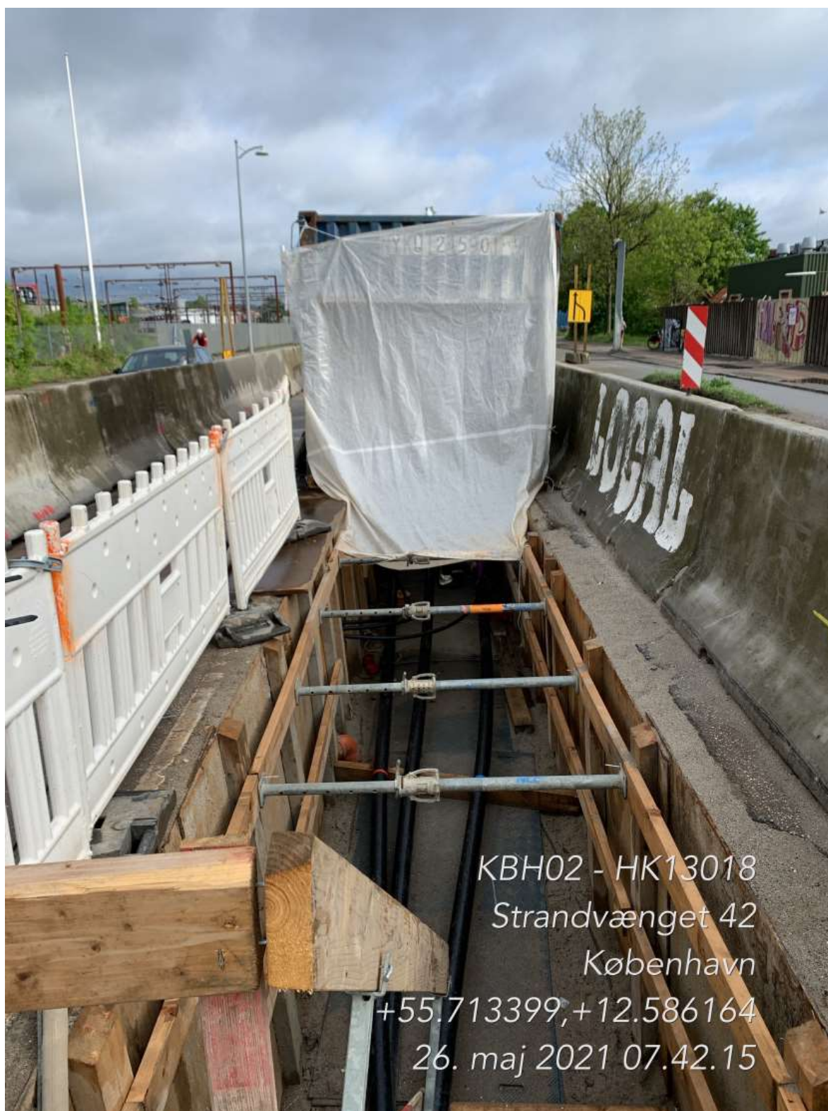
Figur 2-7: Eksempel på opstilling af container til samling af kabelmuffer. Fasekabler er ført ind i begge ender af containeren, som er lukket mest mulig af for at kunne samle kablerne under rene, tørre og opvarmede forhold.
