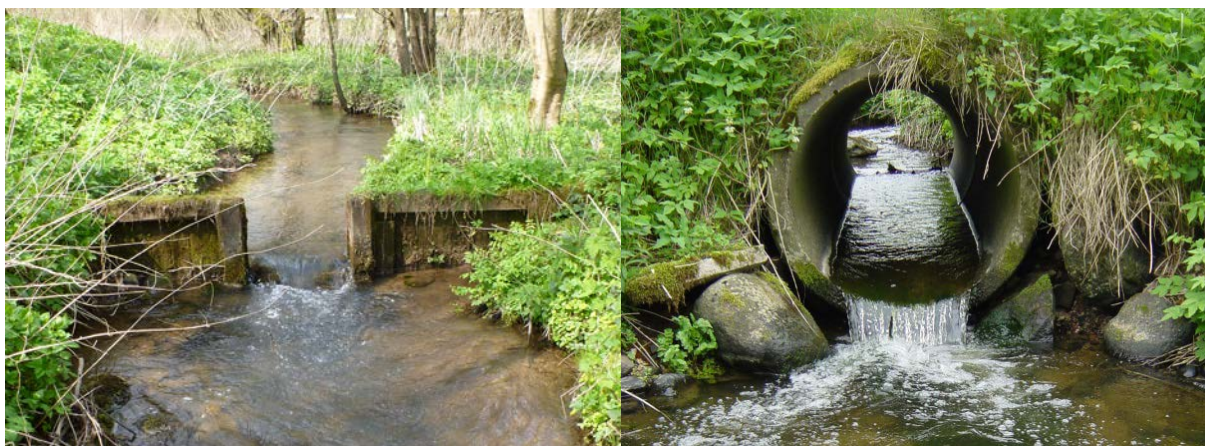
Udlægning af gydegrus kan forbedre passageforholdene mange steder, hvor små styrt og vejunderrør forhindrer, at faunaen kan foretage naturlige vandringer opstrøms.
