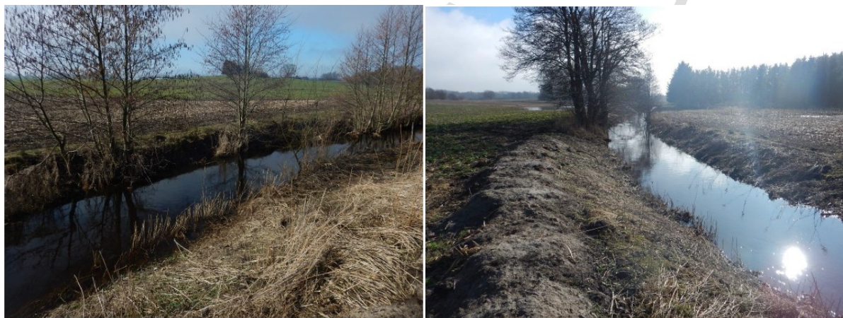
Figur 9. Torpe Kanal ved underbøringslokaliteten set i nedstrøms retning (venstre) og opstrøms retning (højre).
