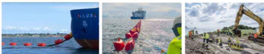
Figur 2-15 Ilandføring af søkabel fra kabelskib med kabelflydere ind i en forberedt rende (fotos fra NKT's hjemmeside).
