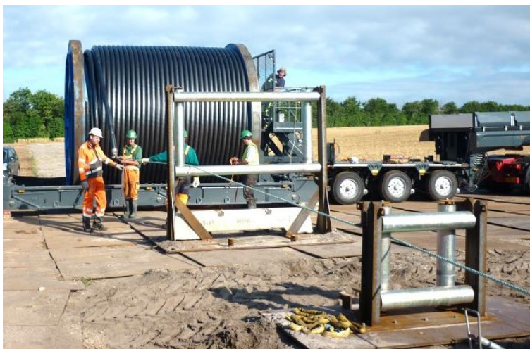
Figur 2-14 Kabeltromle på blokvogn
