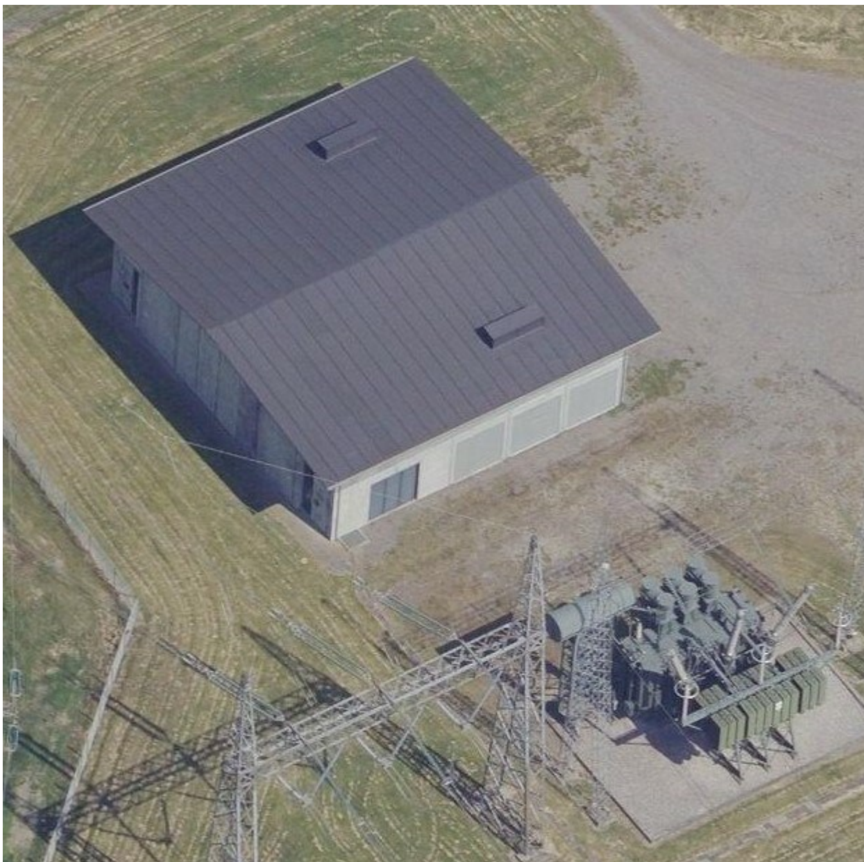
Figur 5-3 Eksempel på en bygning indeholdende et 275 kV-gasisoleret kompakt indendørs koblingsanlæg
