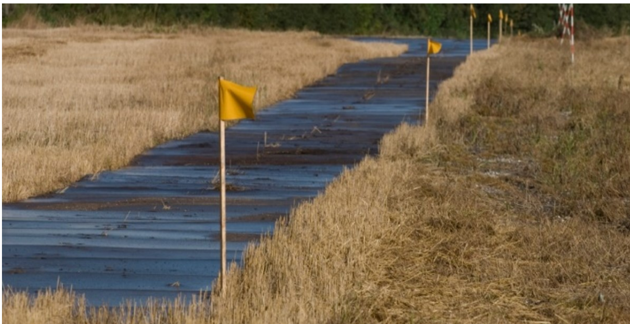
Figur 2-10 Adgangsvej med køreplader
