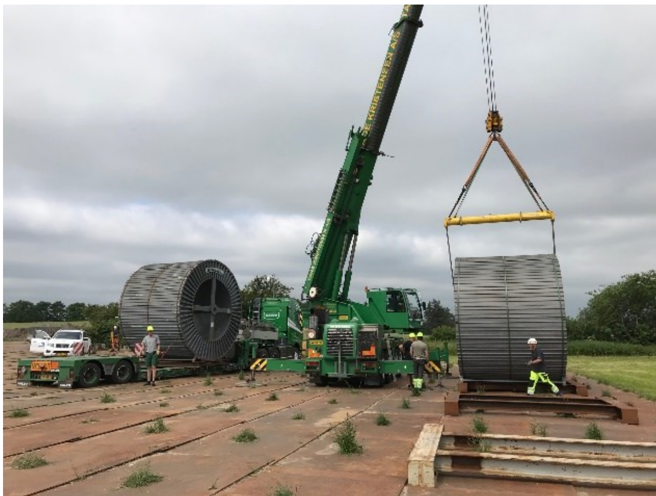
Figur 2-8 Håndtering af kabeltromler på tromleplads
