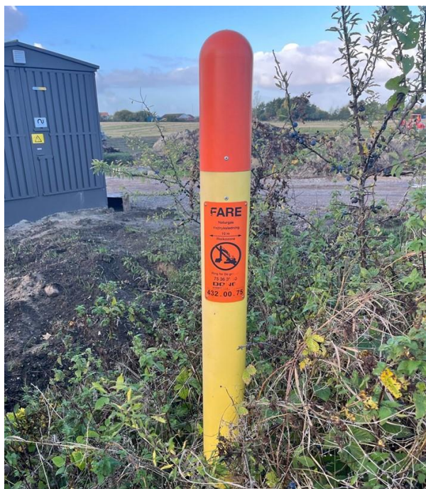
Figur 4: Billede af mærkestander, der markerer F-net ledning
