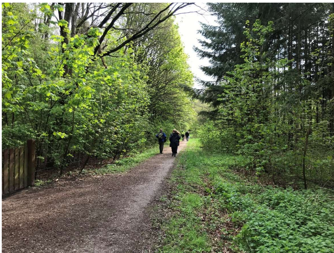
Foto 9: Strækning E set fra vest mod øst. Kablet etableres i grønt areal mellem grussti og nåletræer til højre. Til venstre for grusstien ses låge og hegn til hundeskoven parallelt med stien.
