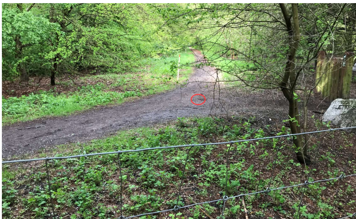
Foto 10: Østlig ende af strækning E set fra øst mod vest. Fotoet er taget bag hegn i hundeskoven. Til højre på foto ses låge fra stien ind i hundeskov. Underboring strækning F udføres fra rød cirkel mod øst (= ind under fotografi).
