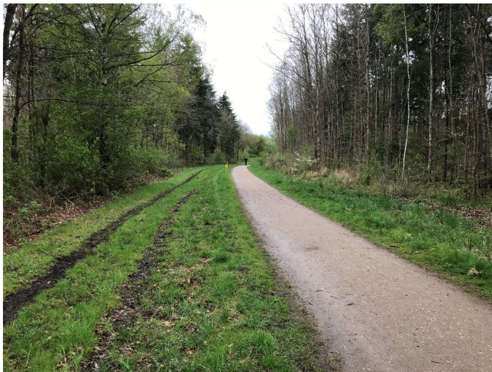
Foto 7: Strækning D set fra øst mod vest. Kabelanlægget etableres i ridesti på græsareal mellem grussti og trægrænse.
