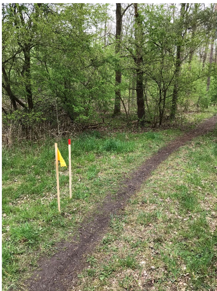
Foto 2: Starten af strækning A. Kabeltracéet fortsætter ligeud i fotoets retning.
