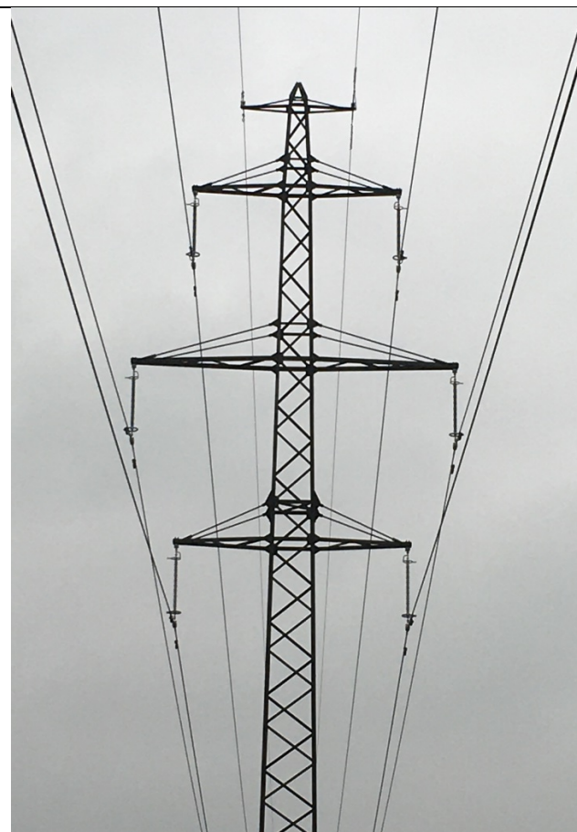
Figur 2-5: Eksempel på mast med nye isolatorkæder af komposit. Isolatorkæderne på masten blev udskiftet i 2020 på strækningen for 132 kV luftledningen Kirkeskovgård-Torslunde. Masten svarer til masterne på projekt Kamstrup-Vejleå
