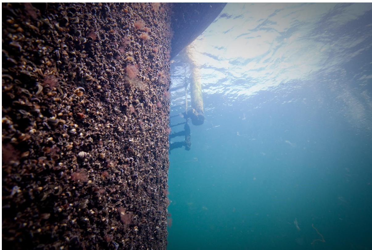
Figur 32 Musslor som etablerats på vindpark Lillgrunds fundament efter endast några år.
