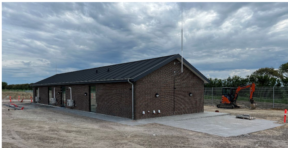
Figur 3-4 Eksempel på bygning på højspændingsstation. Kilde: Energinet.
