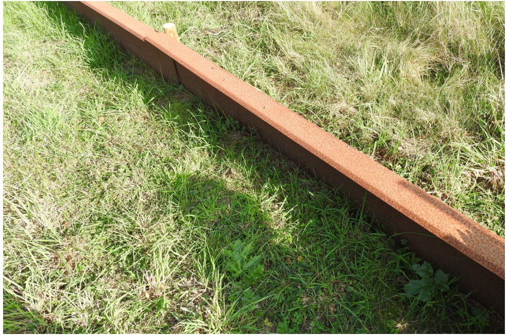
Figur 7-11 Eksempel på midlertidigt padehegn i stål med bukket kant i toppen.
