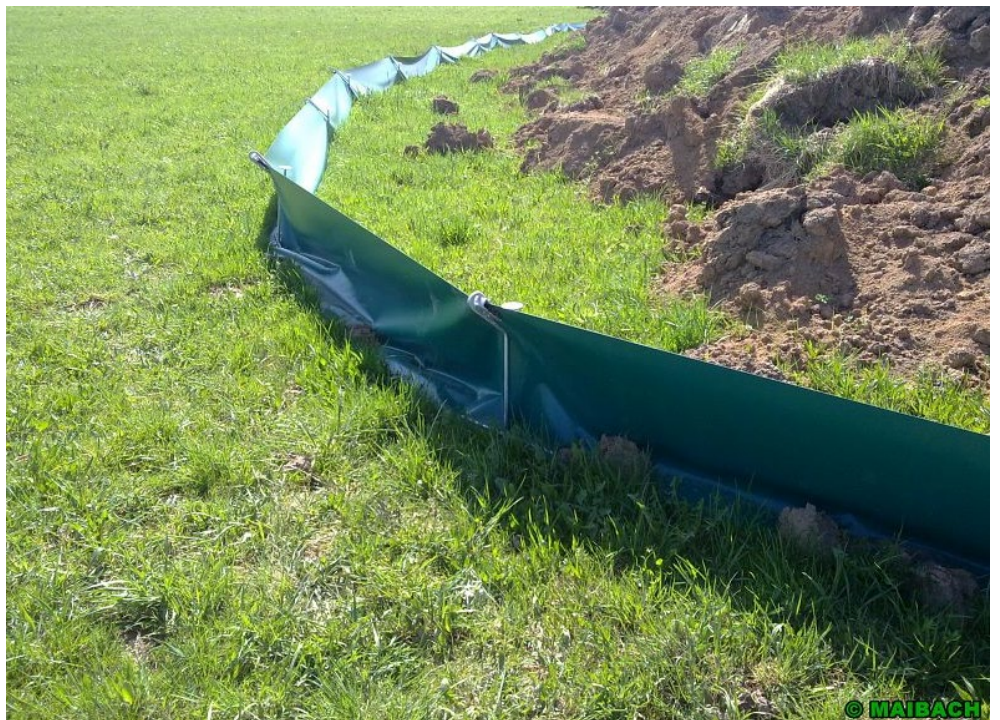
Figur 7-11 Eksempel på midlertidigt padehegn i stål med bukket kant i toppen.
