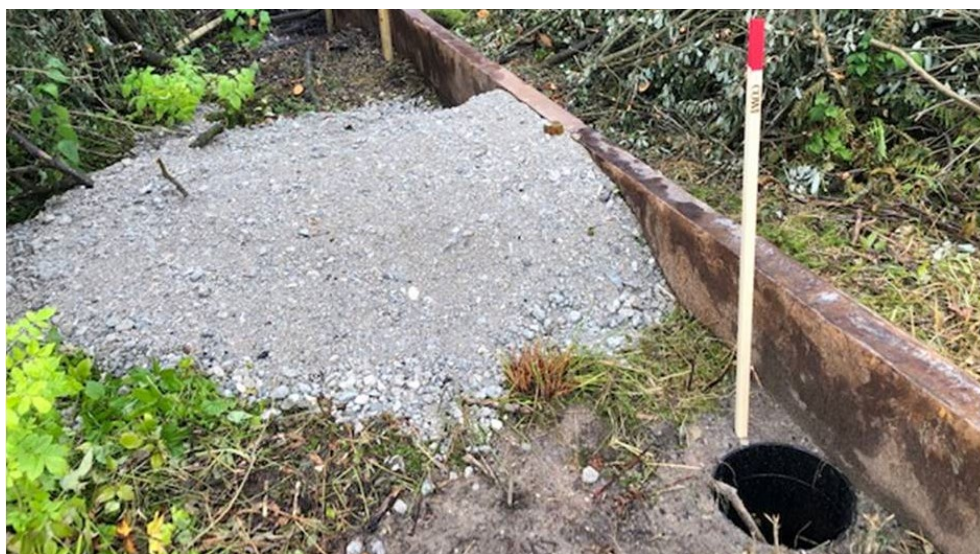
Figur 7-15 Paddehegn med rampe af stabilgrus og spand på indersiden af hegnet.
