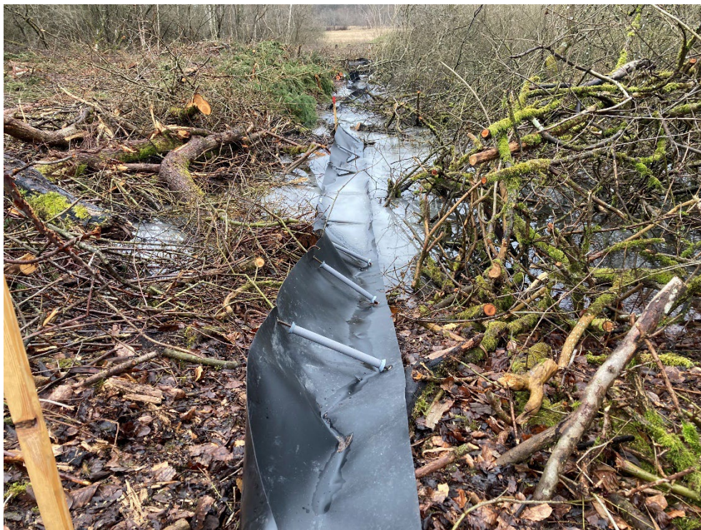
Figur 7-14 Et eksempel på et væltet padderhegn som nemt kan forceres af padder
