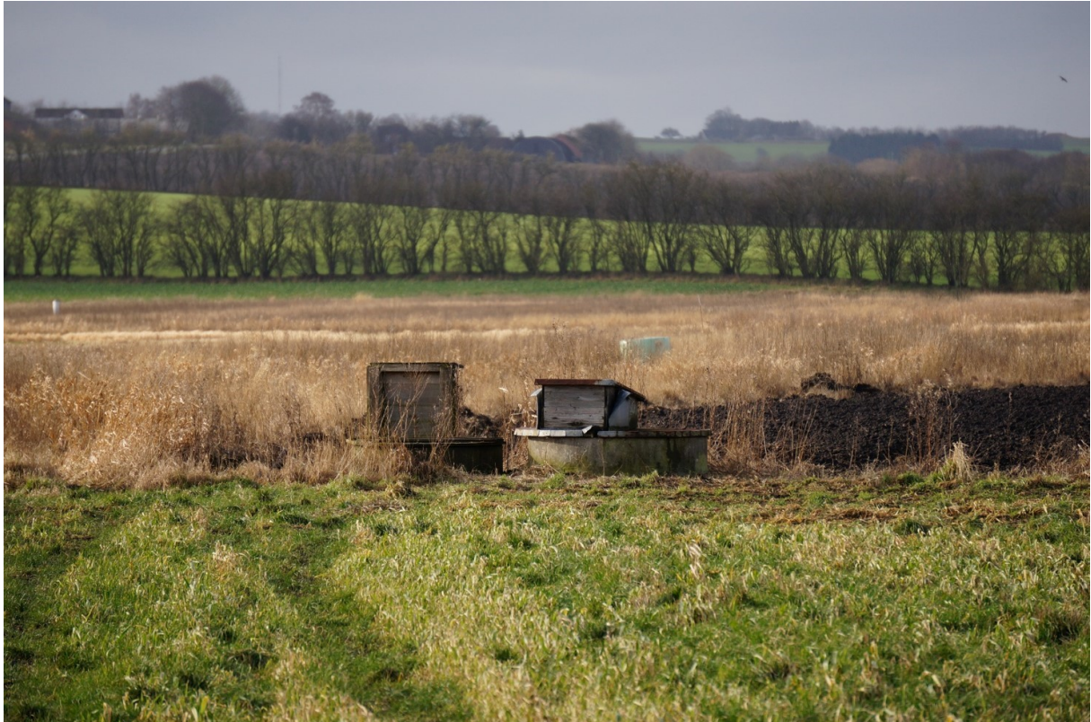
Figur 3 Billede af pumpebrønden ved pumpestationen.
