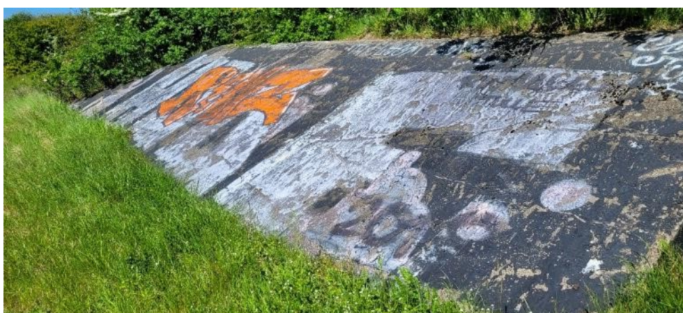
Figur 2-27 Sydvendt betonmur, der potentielt kan benyttes af markfirben til solbadning, såfremt arten findes i området.
