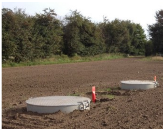
Figur 1.5 Linkboksbrønde til dobbelt kabelsystem.
