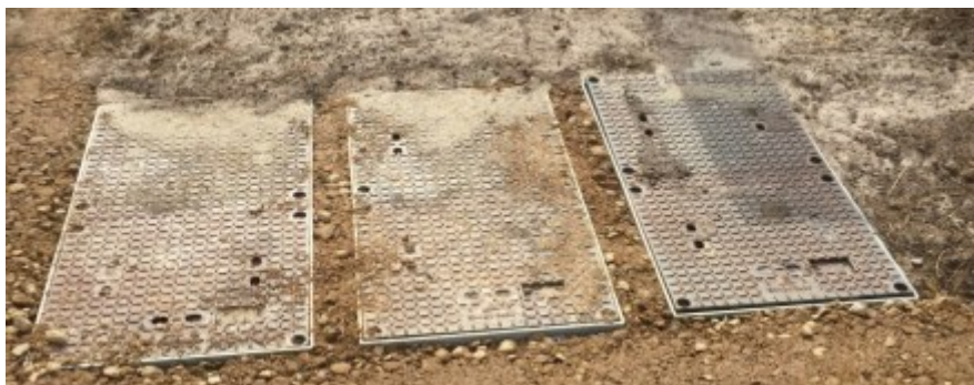
Figur 1.4. Fiberbrønde i et kabelsystem.
