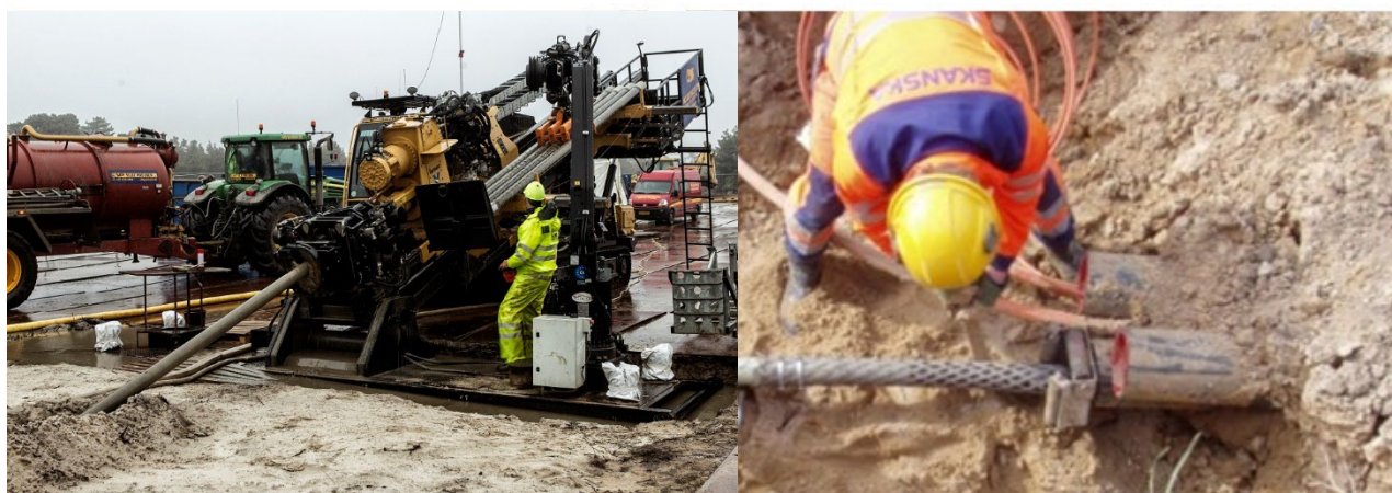
Billede 6. Borerig og trækning af kabler igennem underboring.
