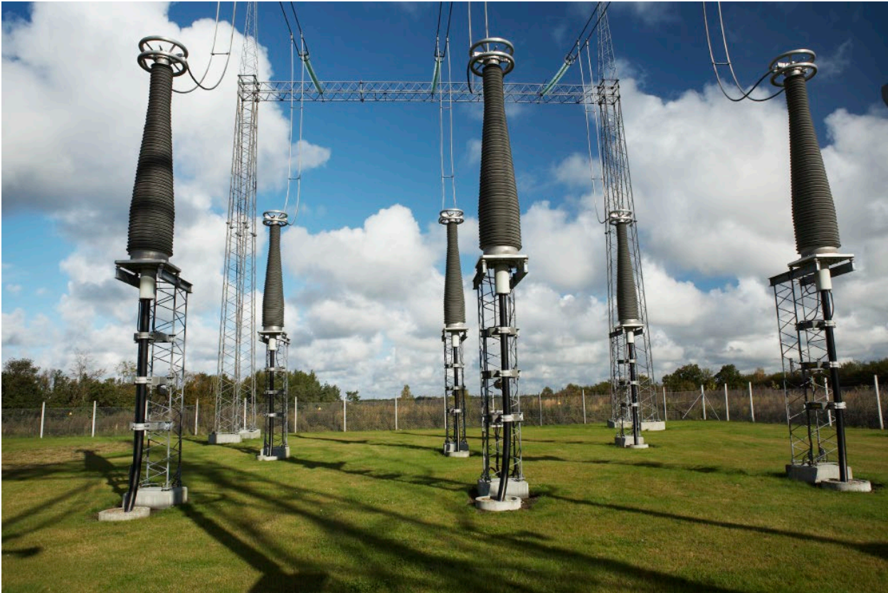
Billede 7. Fundamenter under el-komponenter.
