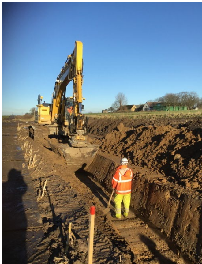
Billede 2. Opgravning af kabelrende til åben grav
