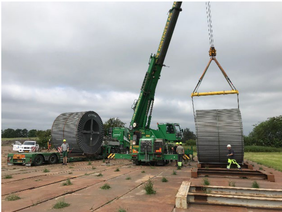
Billede 5. Kabeldepot- og trækplads.
