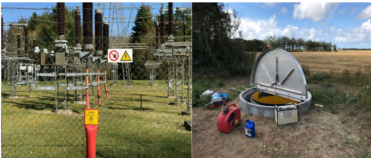
Billede 1. Kabelendeterminering (orange kabel) på station og linkboksbrønd
