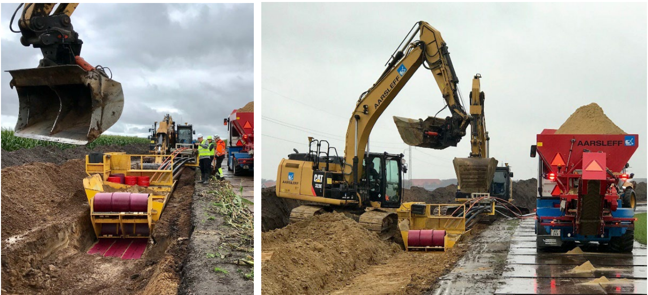
Billede 3. Nedlægning af 150 kV-kabler i flad forlægning ved hjælp af gravekasse.
