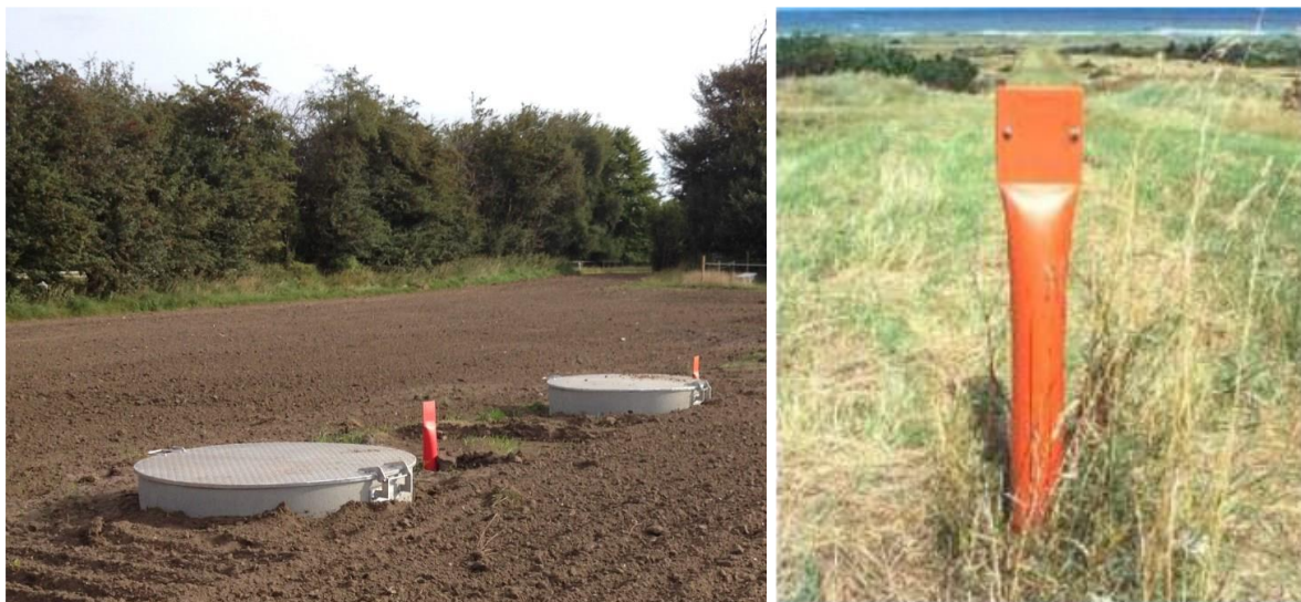
Figur 9: Eksempel på en linkboks (til venstre) og en markeringspæl (til højre) på jordoverfladen.
