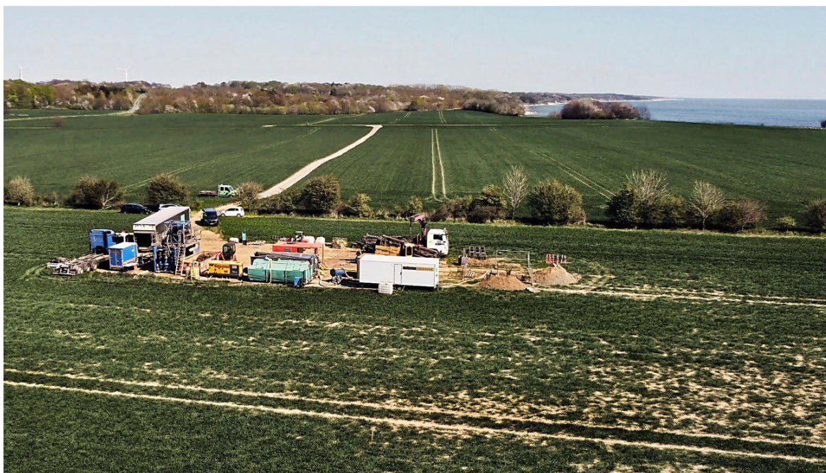
Figur 8: Sådan kan det se ud, når der laves en styret underboring af kysten ved Sose Strand. Billedet er taget ifm. med Energinets geotekniske forundersøgelser. Det ansøgte projekt vil kræve et større arbejdsområde end det viste eksempel.
