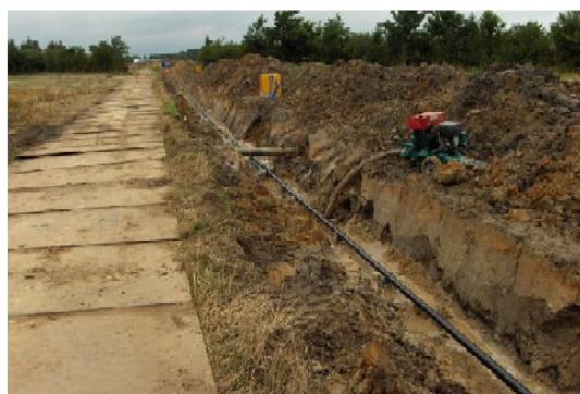
Figur 2-7. Forskellige metoder til at holde kabelgraven tør. På billedet til venstre etableres drænrør, til højre etableres sugespidsanlæg
