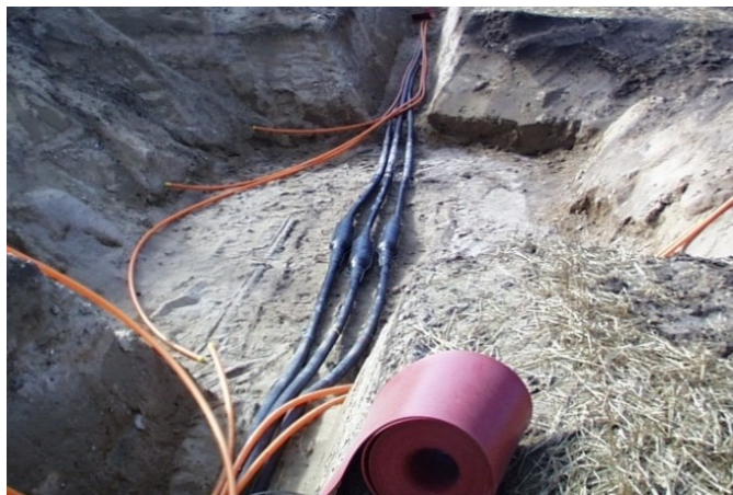
Figur 2-12. Kablerne er muffet sammen
