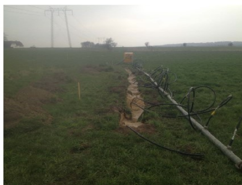
Figur 2-7. Forskellige metoder til at holde kabelgraven tør. På billedet til venstre etableres drænrør, til højre etableres sugespidsanlæg
