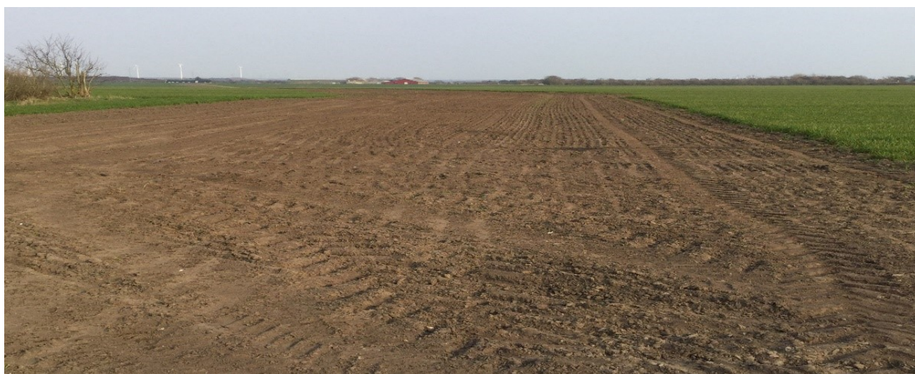
Figur 2-4. Eksempelfoto på udjævnet anlægsbælte.
