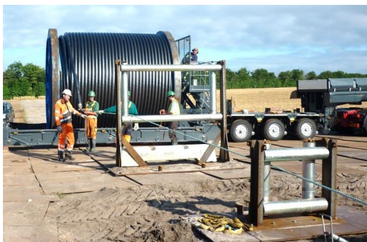
Figur 2-13. Kabeltromle på blokvogn
