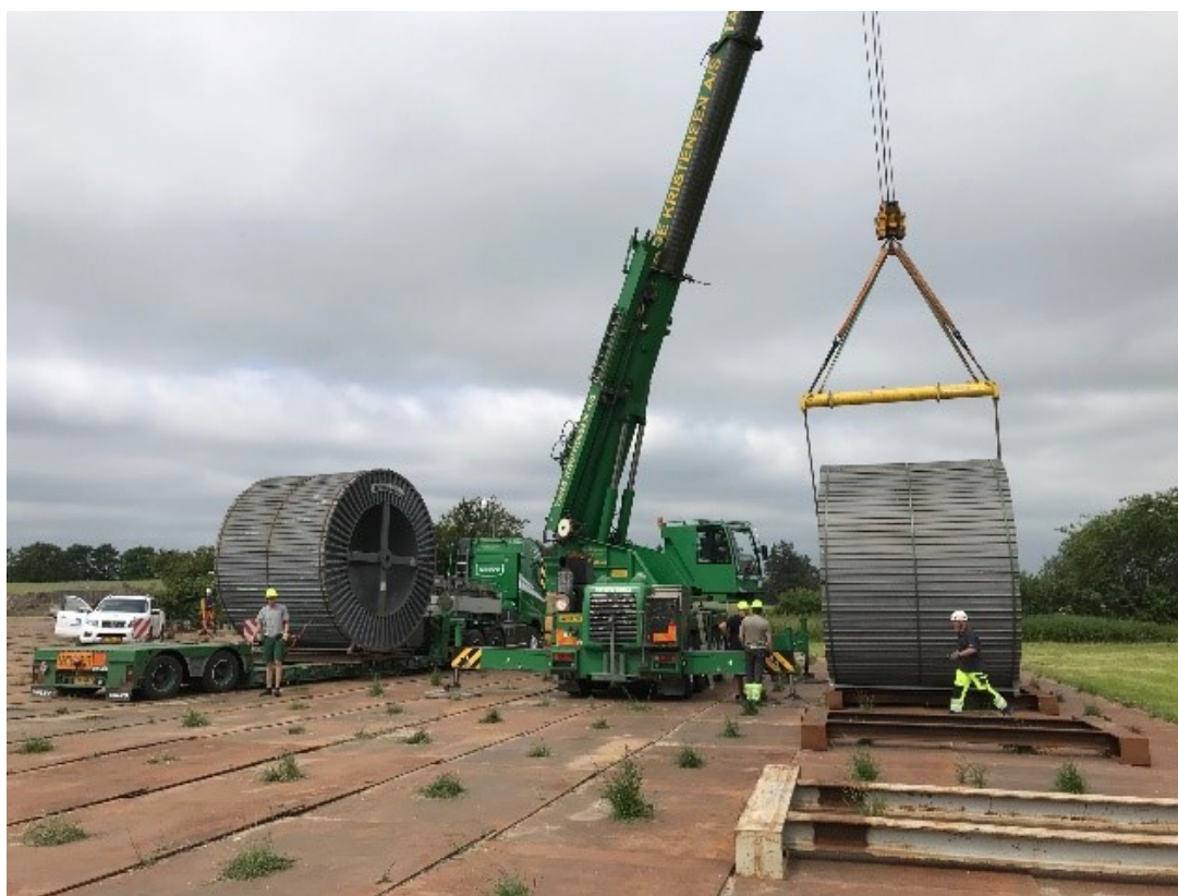
Figur 2-8. Håndtering af kabeltromler på tromleplads
