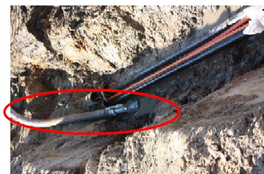
Kabelgraven pumpes med grundvandspumper
