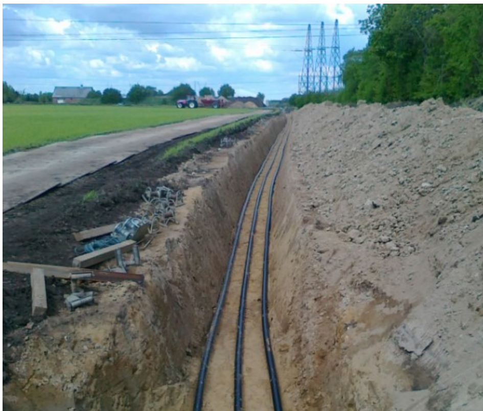
Figur 2-5. Kabelanlæg lagt ud i åben grav. Kabelruller benyttet ved udtrækningen af kabler kan ses på siden af kabelgraven.
