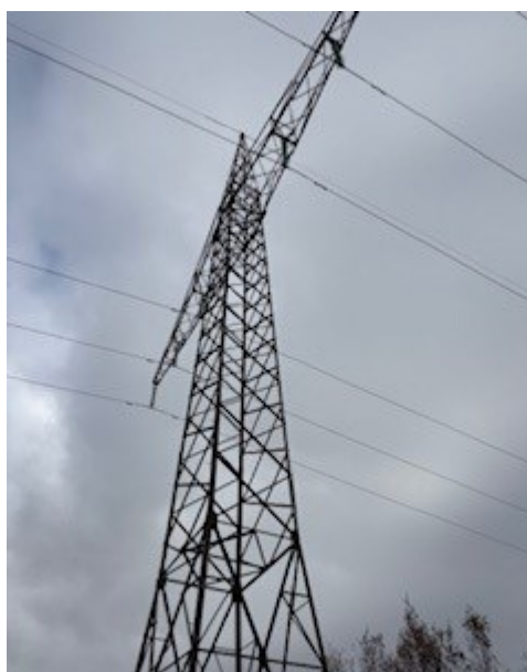
Figur 2-3. Eksempel på bæremast (mast 24)
