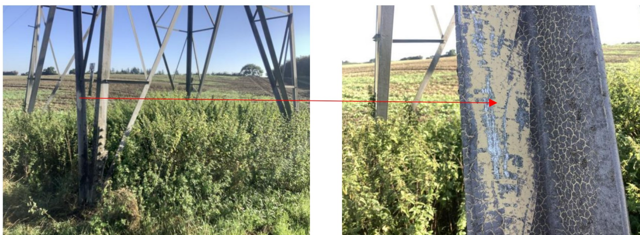
Figur 2-30. Eksempel på prøvetagning fra mast.
