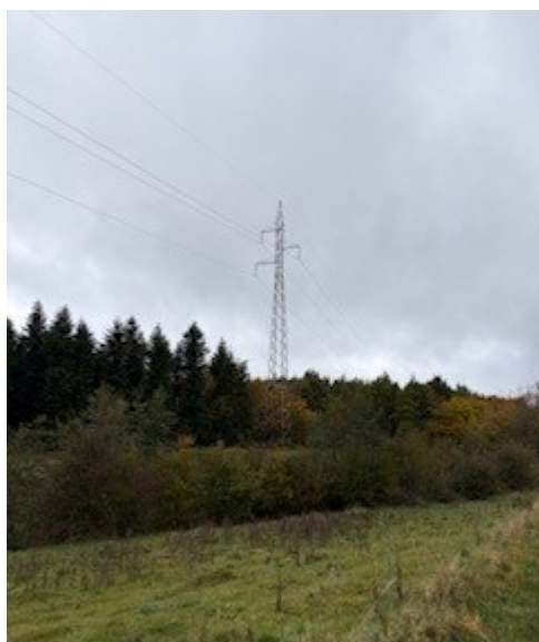
Figur 2-2. Eksempel på bæremast (mast nr. 30).
