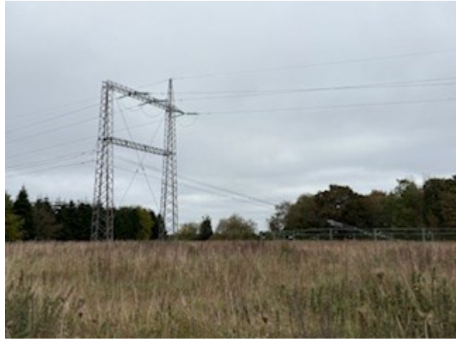
Figur 2-5. Mast 1. Afspændingsknækmast. Den tidligere 220 kV forbindelse er taget ned hertil og bruges som anker.
