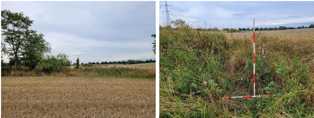
Figur 2 Fotos af det potentielle gennembrudssted. På fotoet til venstre ses diget fra nord, og landmålerstængerne er placeret 16 m fra hinanden. Til højre ses et nærbillede af diget, hvor de vandrette landmålerstænger angiver toppen og foden af diget.
