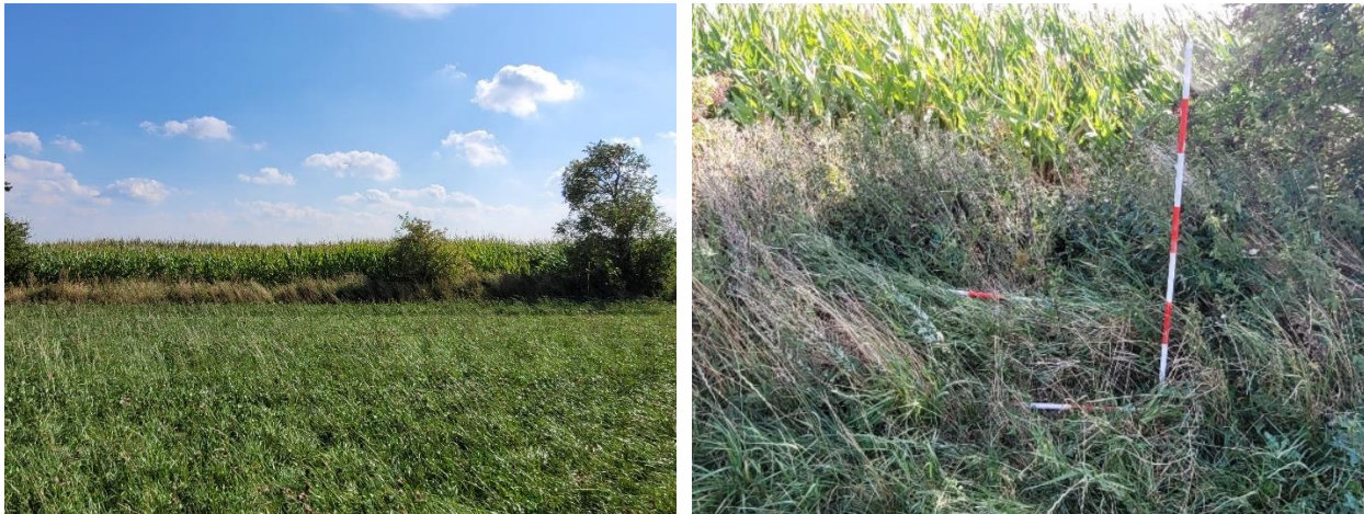
Figur 5 Fotos af det potentielle gennembrudssted. På fotoet til venstre ses diget fra vest, og landmålerstængerne er placeret 16 m fra hinanden. Til højre ses et nærbillede af diget, hvor de vandrette landmålerstænger angiver toppen og foden af diget.
