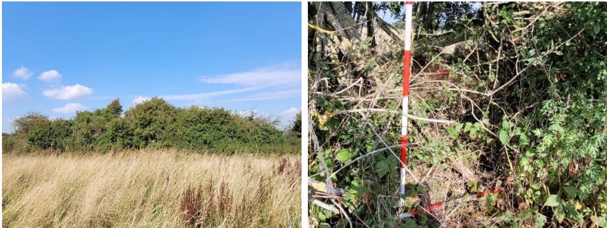
Figur 6 Fotos af det potentielle gennembrudssted. På fotoet til venstre ses diget med tilhørende hegn fra øst, og landmålerstængerne er placeret 16 m fra hinanden. Til højre ses et nærbillede af diget, hvor de vandrette landmålerstænger angiver toppen og foden af diget.
