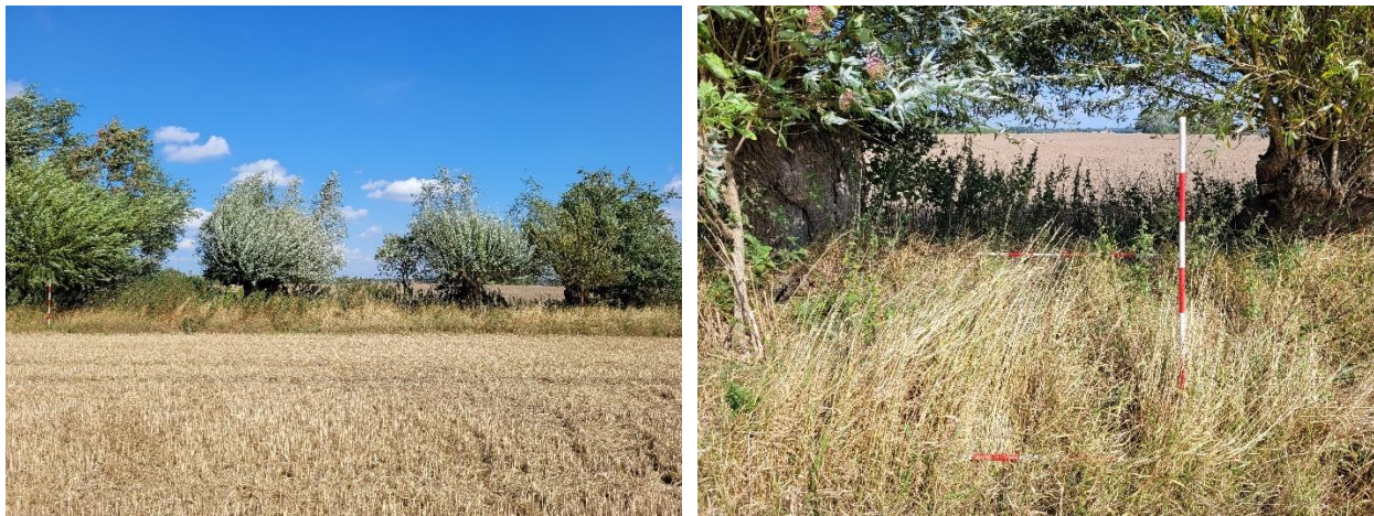
Figur 4 Fotos af det potentielle gennembrudssted. På fotoet til venstre ses diget med tilhørende hegn fra syd, og landmålerstængerne er placeret 16 m fra hinanden. Til højre ses et nærbillede af diget, hvor de vandrette landmålerstænger angiver toppen og foden af diget.
