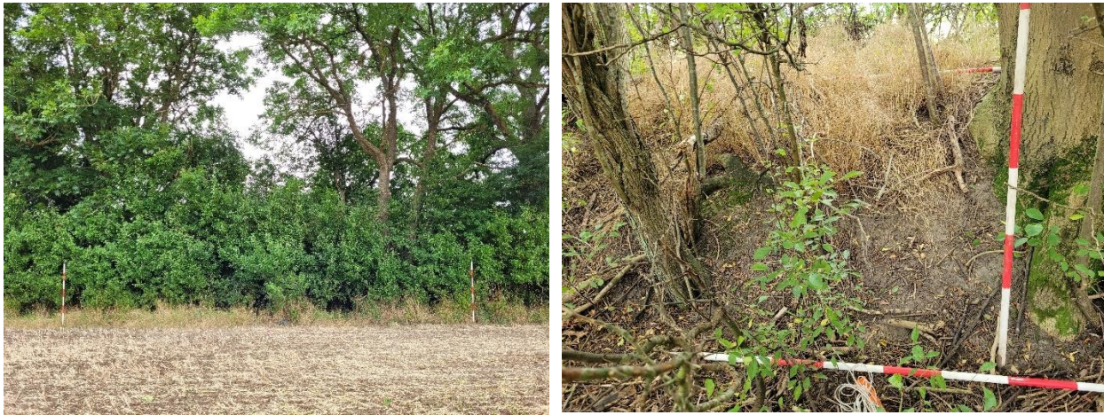
Figur 9 Fotos af det potentielle gennembrudssted. På fotoet til venstre ses diget med tilhørende hegn fra vest, og landmålerstængerne er placeret 10 m fra hinanden. Til højre ses et nærbillede af diget, hvor de vandrette landmålerstænger angiver toppen og foden af diget.
