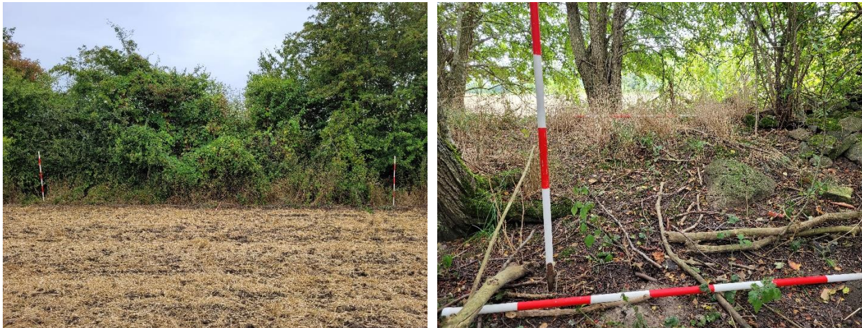
Figur 10 Fotos af det potentielle gennembrudssted. På fotoet til venstre ses diget med tilhørende hegn fra øst, og landmålerstængerne er placeret 10 m fra hinanden. Til højre ses et nærbillede af diget, hvor de vandrette landmålerstænger angiver toppen og foden af diget.
