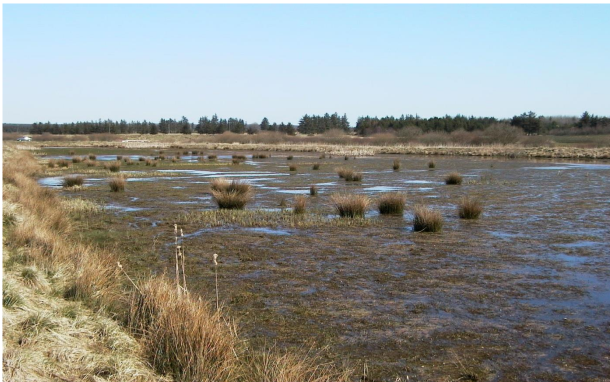
Fig. 3: Stort lavteknologisk okkerrensninganlæg ved Abild å, med god grødeudvikling og god renseseffekt.
