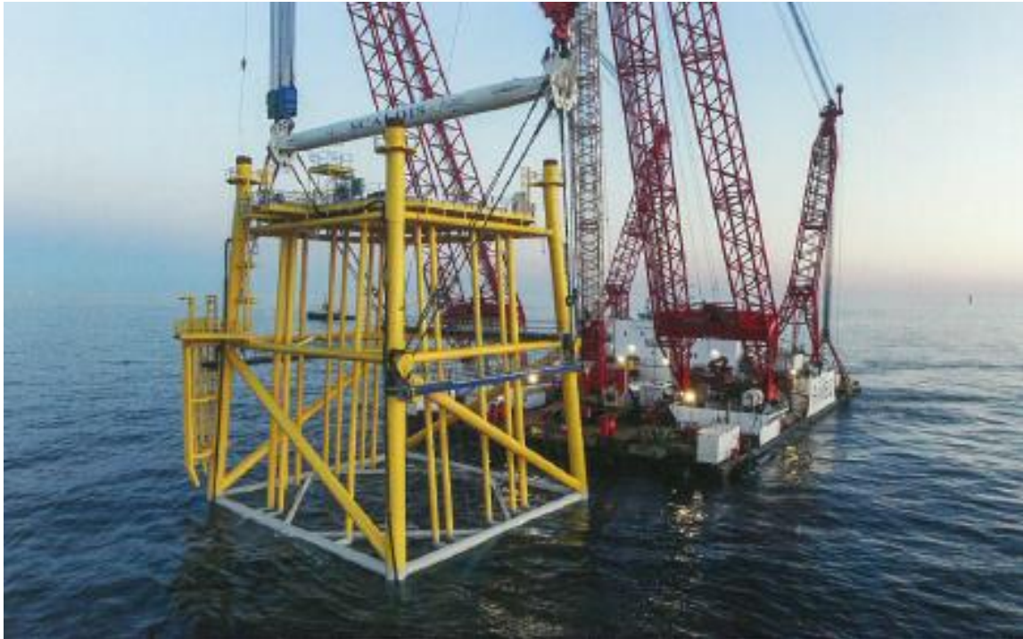
Figur 25: Sænkning af fagværksfundamentet til en offshore transformerstation før ned (Kilde: Van Oord, Gemini Offshore Wind Park - a giant step towards a sustainable future, 2017)
