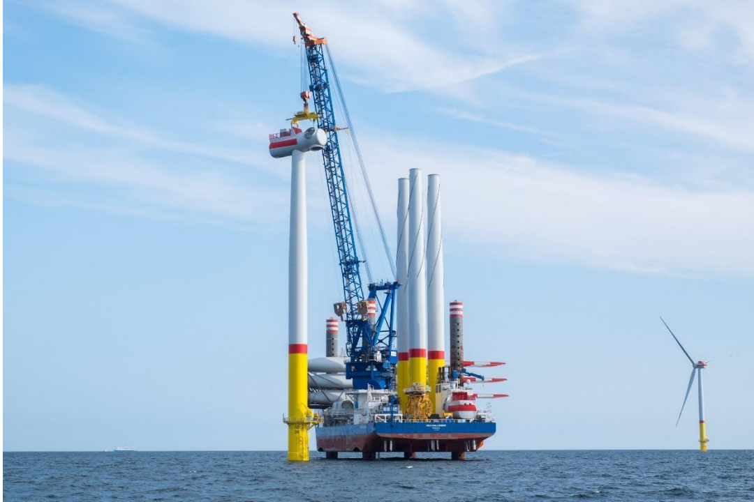
Figur 7. Vindmøletårne under installation i Arkona offshore vindmøllepark (foto er fra RWE resources)
