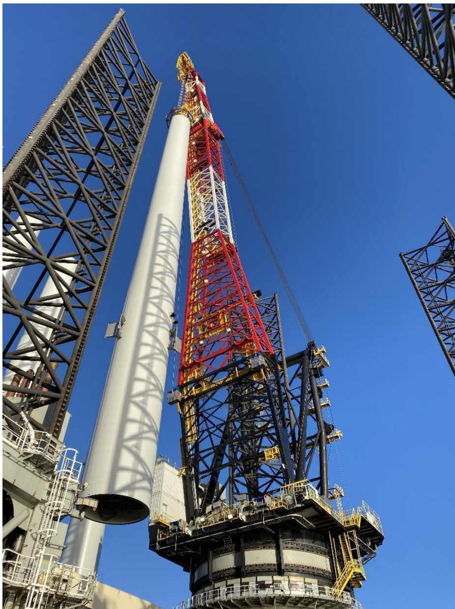
Figur 6: Forberedelse til placering af vindmølletårnet på Triton Knoll OWF overgangselement (foto er fra RWE Resources)
