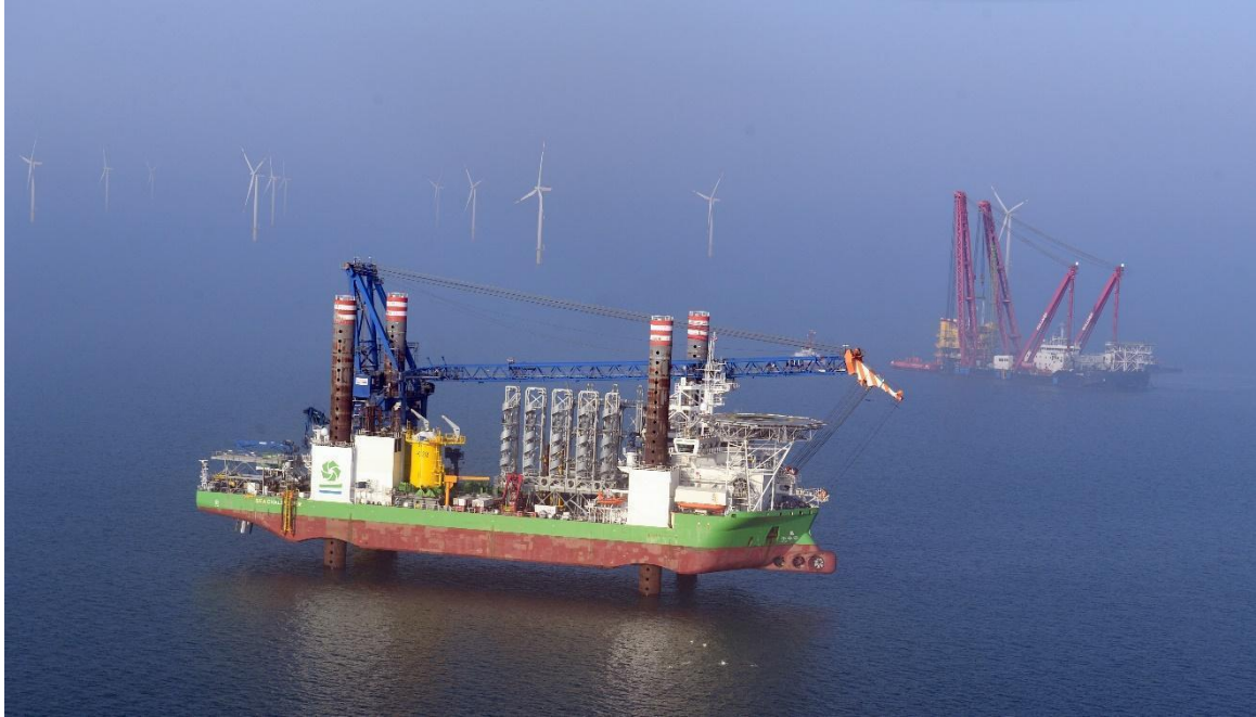
Figur 20: Transport af overgangselementer og monopæle til installationsstedet (foto fra RWE's egne ressourcer)
