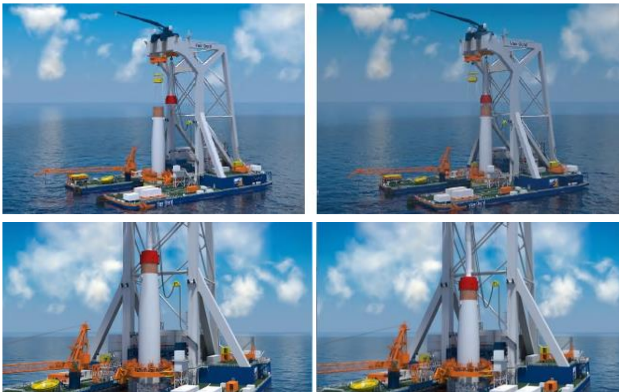
Figur 21. Placering af den hydrauliske hammer direkte over monopælen for at sænke den ned i havbunden (Kilde: Van Oord, Offshore monopile installation, Quick Guide rev.1, 01.08.2018)
