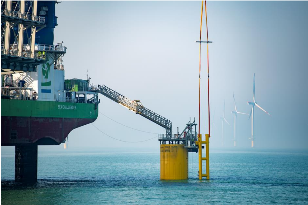
Figur 8. Overgangselement placeret på en sænket monopæl (foto fra RWE's egne ressourcer)
