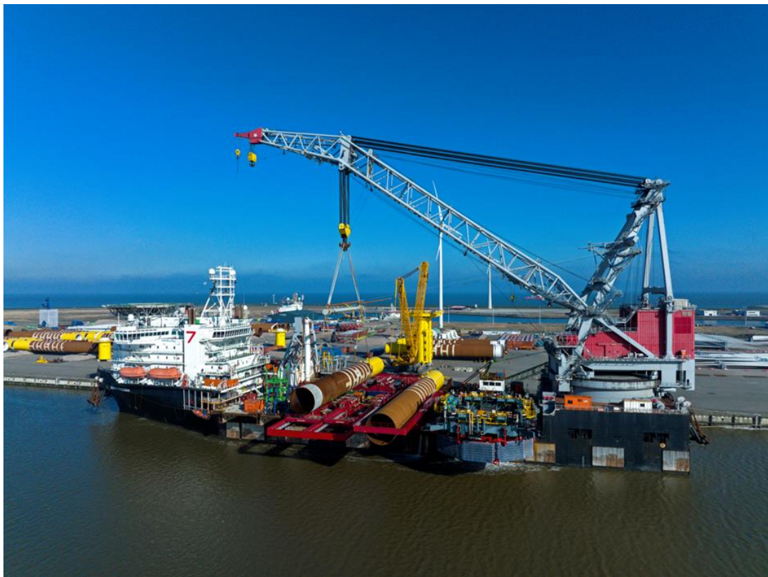
Figur 19. Monopal-fundamentbelastning ved hjælp af en kran (foto fra RWE's egne ressourcer)
