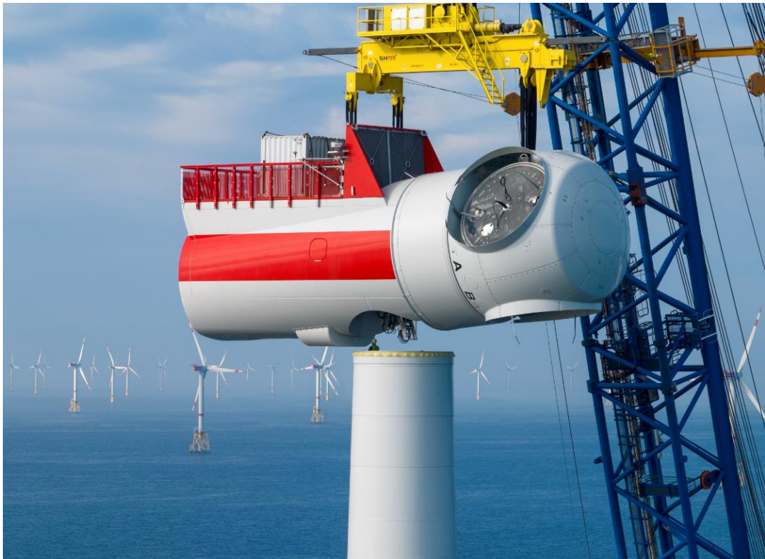
Figur 4: Udsigt over havvindmøllens nacelle under installation. Kaskasi vindmøllepark (foto er fra RWE resources).
