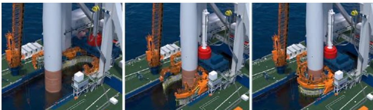
Figur 23: Monopæl holdt i lodret position ved hjælp af en specialiseret griber (kilde: Van Oord, Offshore monopile installation, Quick Guide rev.1, 01.08.2018)
