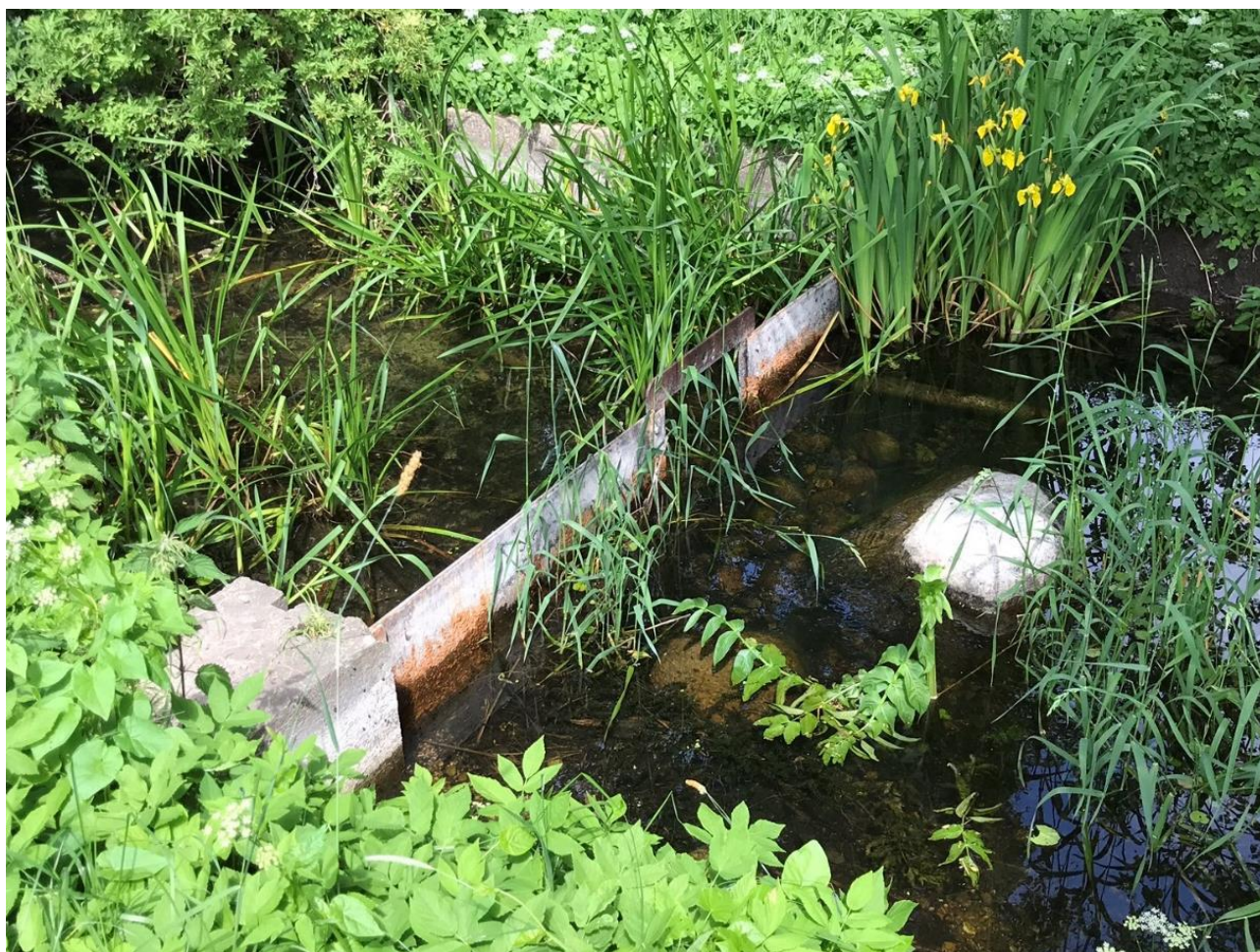
Figur 13 - Det eksisterende stemmeværk i kanalen, som forbinder Søndersø og Tibberup Å, juni 2020. De grå streger markerer placeringen af en rørgennemføring i den østlige side af stemmeværket.
