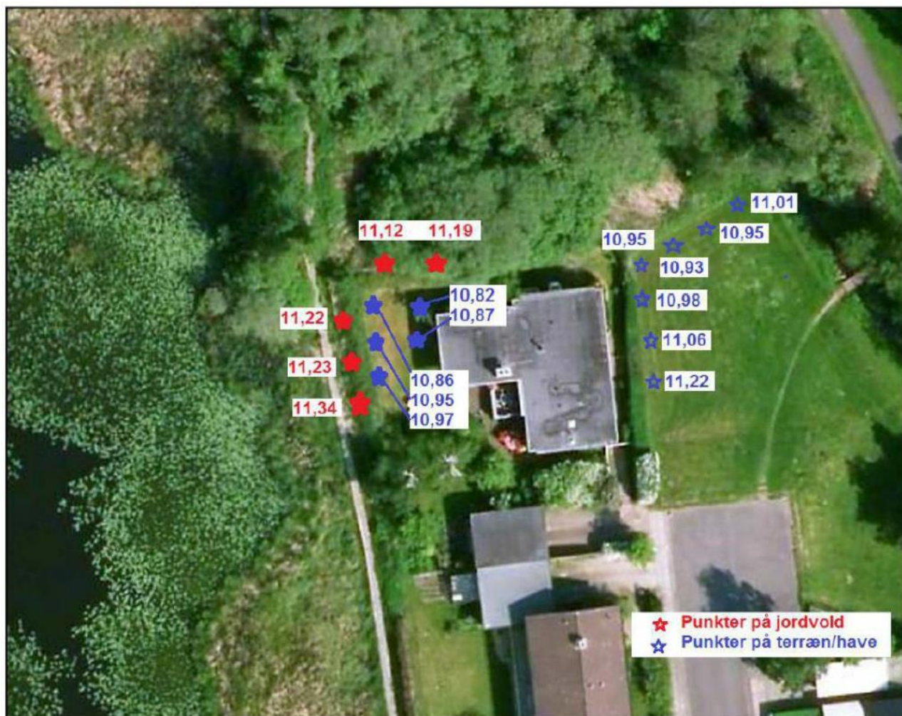
Figur 15 - Målinger af terrænkote ved en lavliggende ejendom i Mølle dalen, 3500 Værløse /25/.
