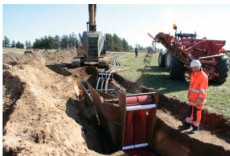
Figur 29 Kabellægning med gravekasse
