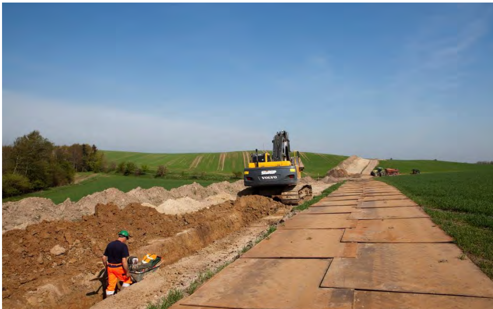
Figur 27 Eksempel på arbejdsbælte med afrømmet rå- og muldjord samt køreplader. Bemærk, at dette et tracé med et kabelsystem.
