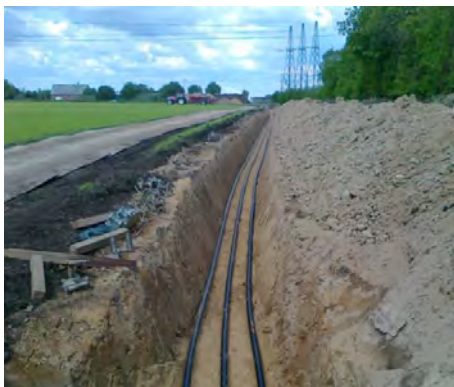
Figur 28 Eksempel på en kabelgrav lige efter udtrækning af kabler.
