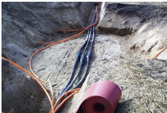
Figur 2-33 Kablerne er muffet sammen
