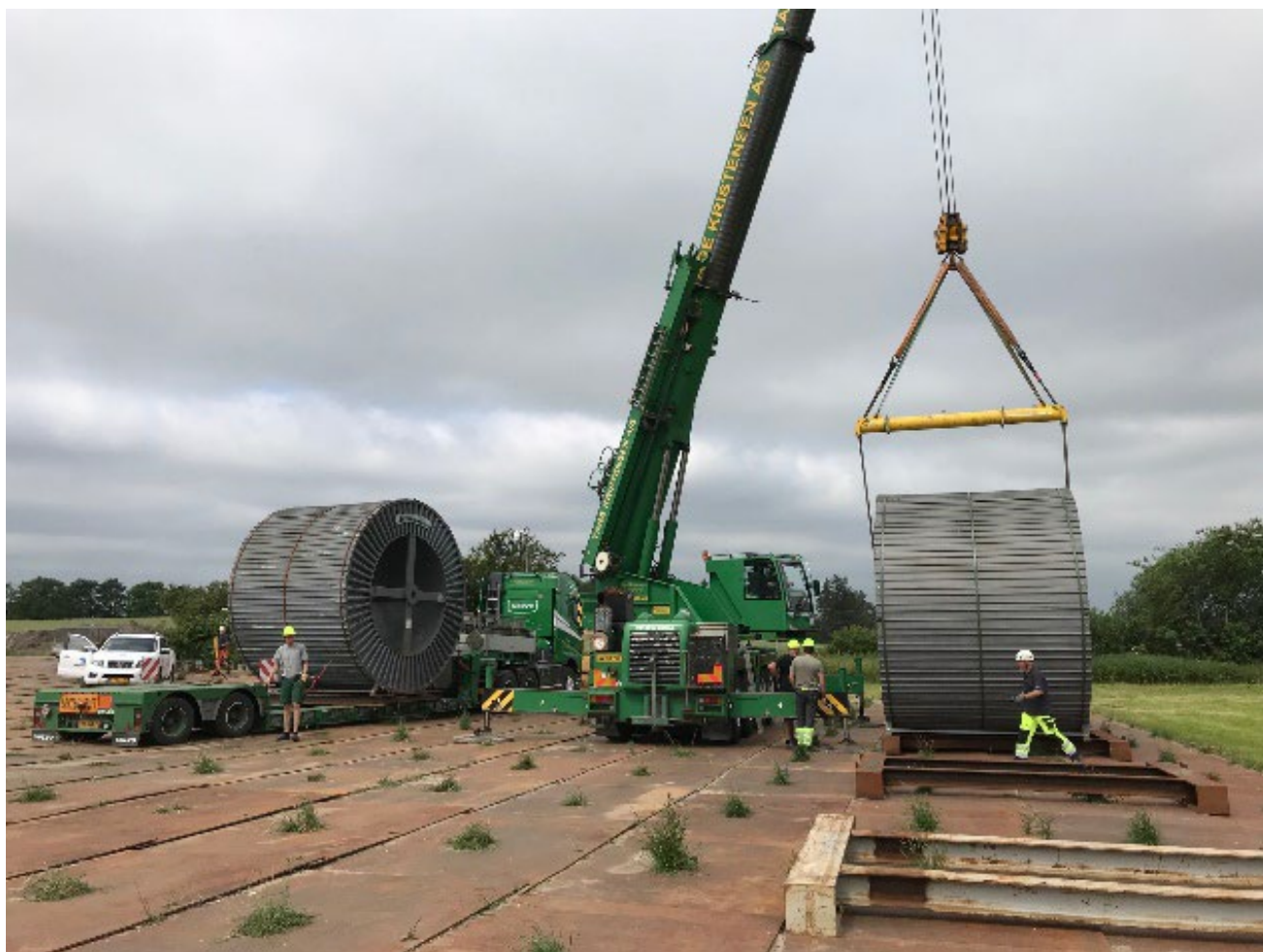
Figur 2-8 Håndtering af kabeltromler på tromleplads
