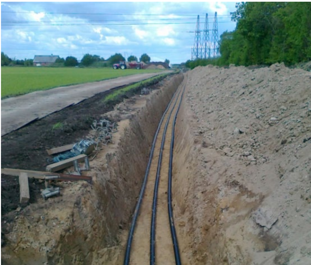
Figur 2-6 Kabelanlæg lagt ud i åben grav
