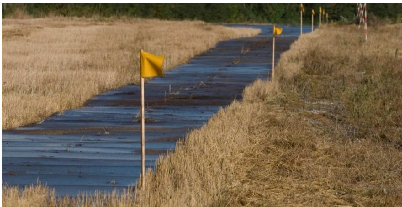
Figur 2-10 adgangsvej med køreplader
