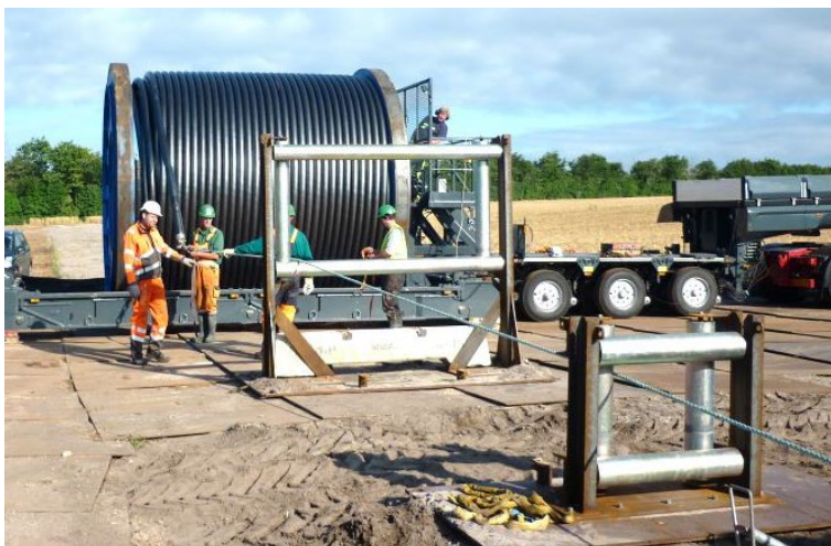
Figur 2-44 Kabeltromle på blokvogn
