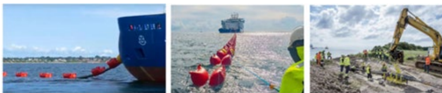
Figur 2-55. Ilandføring af søkabel fra kabelskib med kabelflydere ind i en forberedt rende (fotos fra NKT's hjemmeside).
