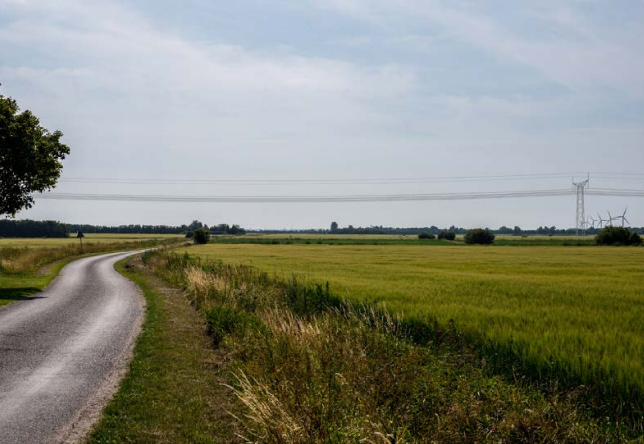
18: Vestermarksvej, Roager. Visualisering af fremtidige forhold. Det nye 400 kV anlæg er markant større end det nuværende 150 kV luftledningsanlæg. De tykkere kabler opleves som visuelt forstyrrende for oplevelsen af vid udsigt over det åbne landskab. Bemærk, at den eksisterende 150 kV ledning, som er synlig på placeringen i dag, er bortretoucheret.
