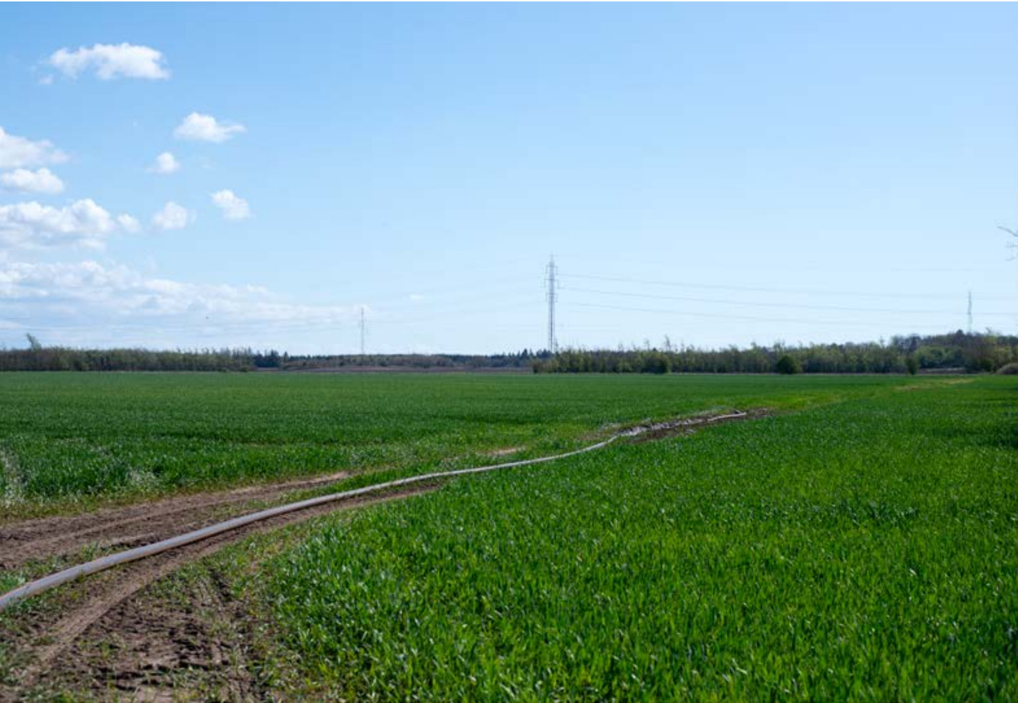
26: Trælborgvej, Bredebro. Eksisterende forhold. Fotoet er taget fra den lille lokalvej Trælborgvej, hvor det eksisterende højspændingsanlæg ses over markerne.
