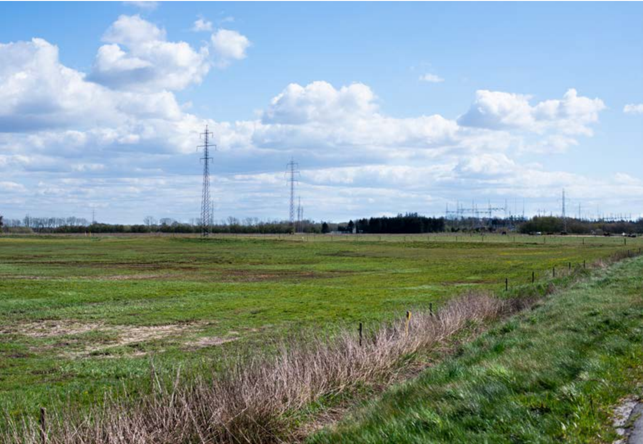
25: Bredebro. Eksisterende forhold. Fotoet er taget fra Hovedvejen umiddelbart øst for Brede Kirke hvorfra den den eksisterende transformerstation ses tydeligt.
