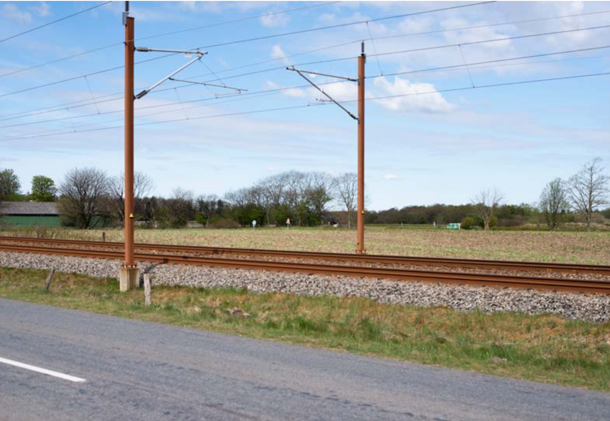
8: Øst for Bramming. Eksisterende forhold. Fotoet er taget fra Gørdingvej, hvor det nye højspændingsanlæg krydser Kolding-Esbjerg banen.
