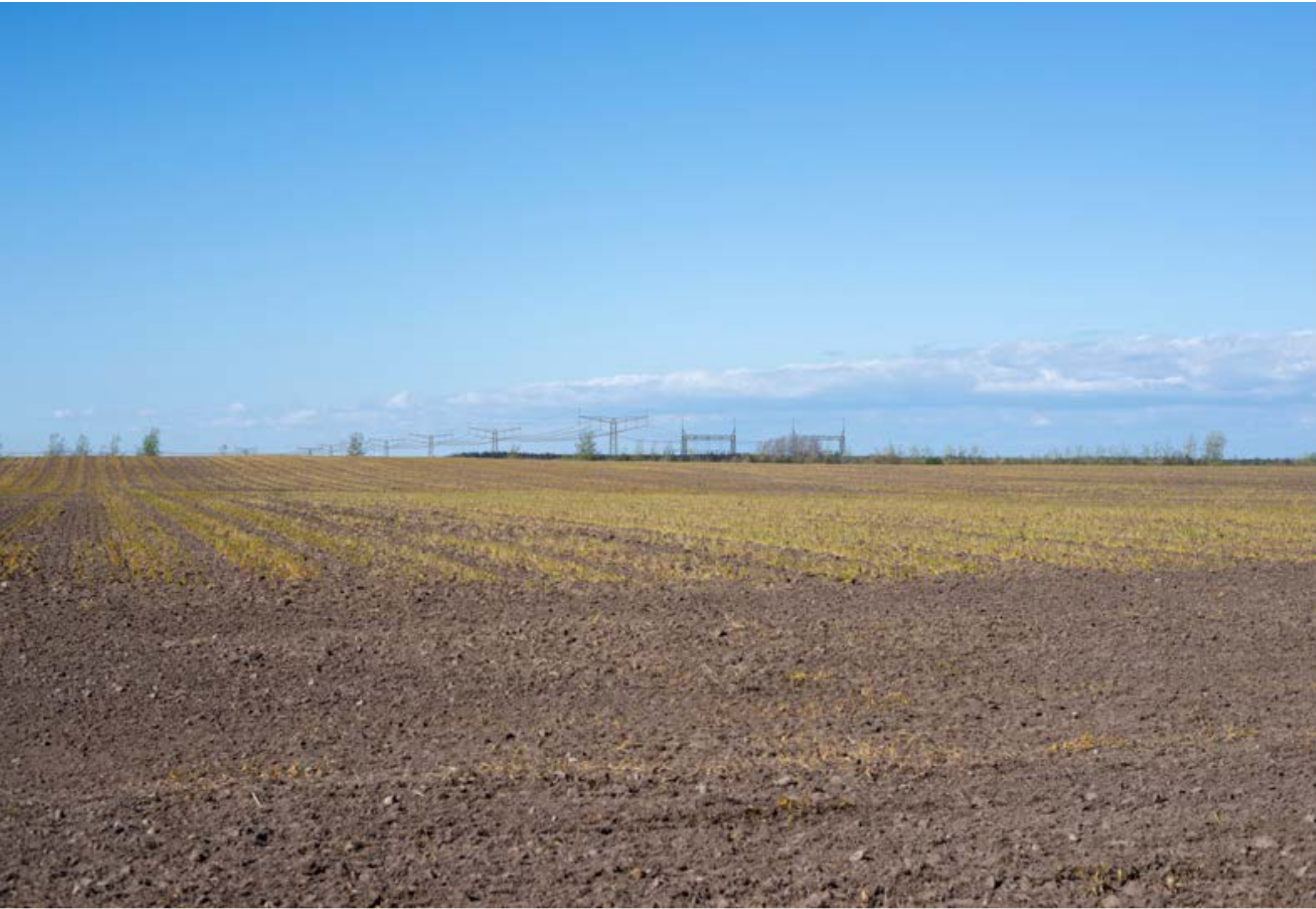
29: Rørkær. Visualisering af fremtidige forhold. Det nye luftledningsanlæg og kabeanlægget vil være markant synligt i det åbne landskab.
