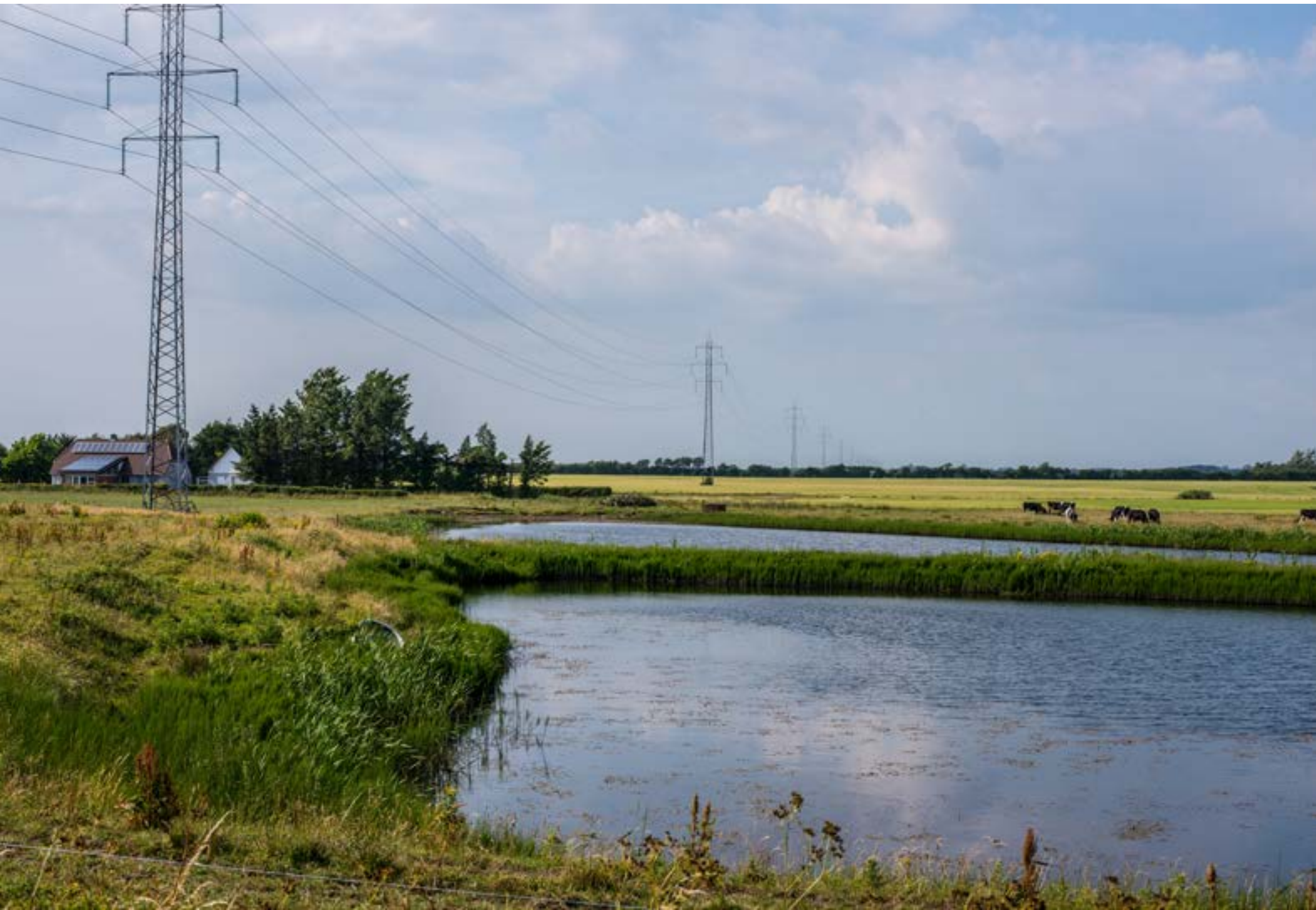
19: Frifeltvej set mod nord. Eksisterende forhold. Fotoet er taget fra landevejen omtrent midt imellem Frifelt og Birkelev. Det eksisterende 150 kV anlæg ses tydeligt.
