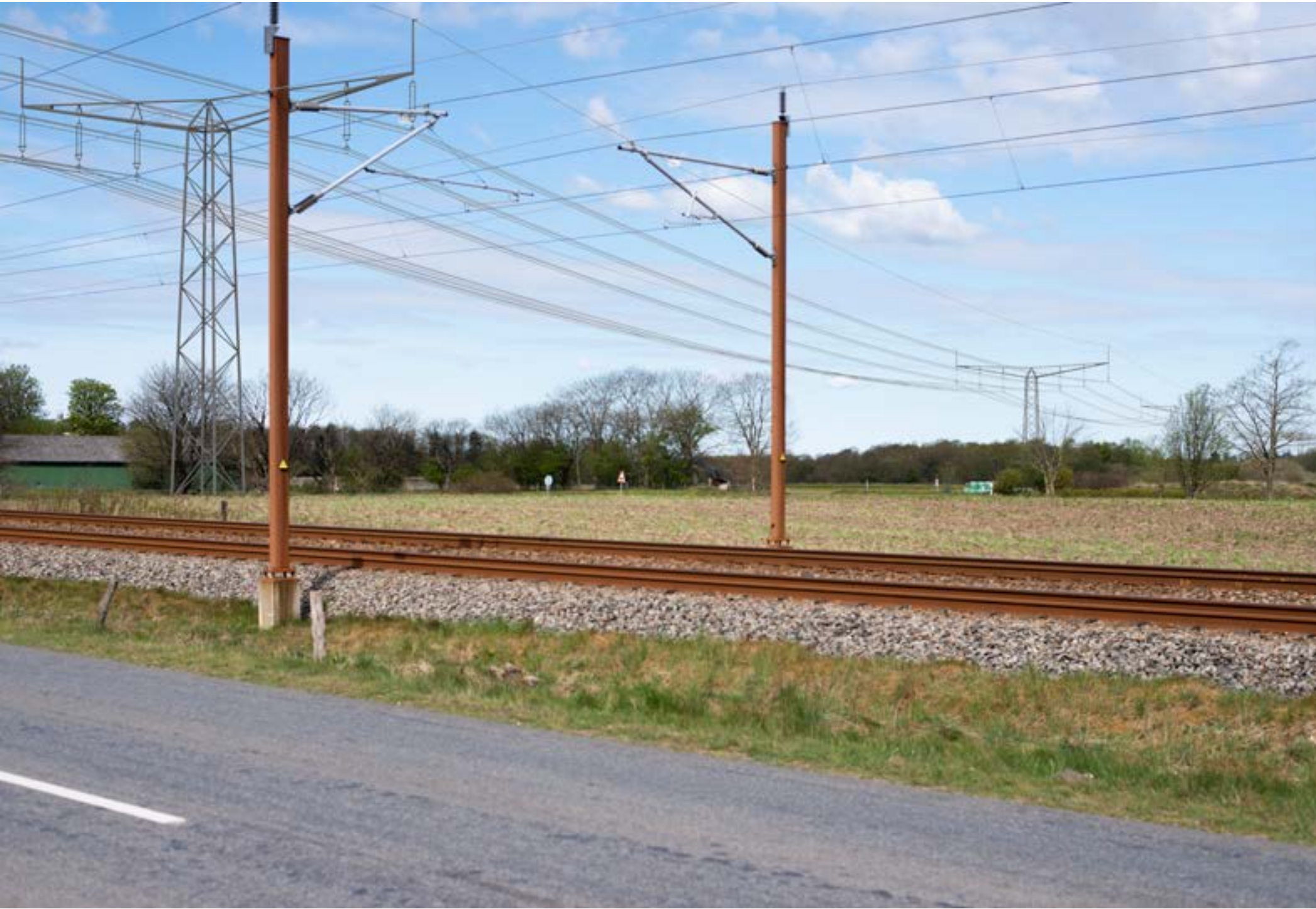
8: Øst for Bramming. Visualisering af fremtidige forhold. Det nye luftledningsanlæg vil være markant synligt i det åbne landskab og vil, sammen med det eksisterende kørestrømsanlæg langs banen, øge det tekniske præg i området.
