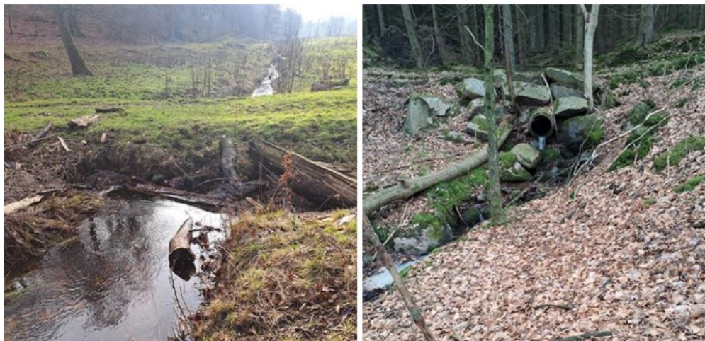
Figur 4-20 Rør som fjernes fra hhv. Læså og Kværnbæk
