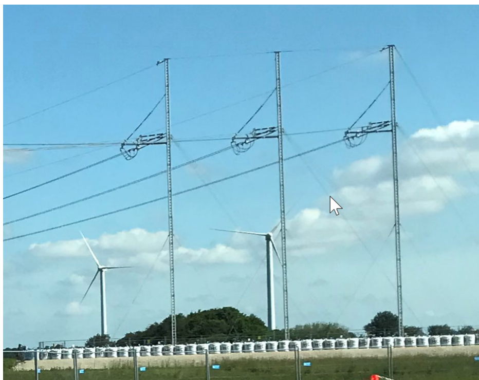
Figur 2. Foto der viser den type knækmast der anvendes. Bardunerne til fastgørelse af masterne fremgår ligeledes.
