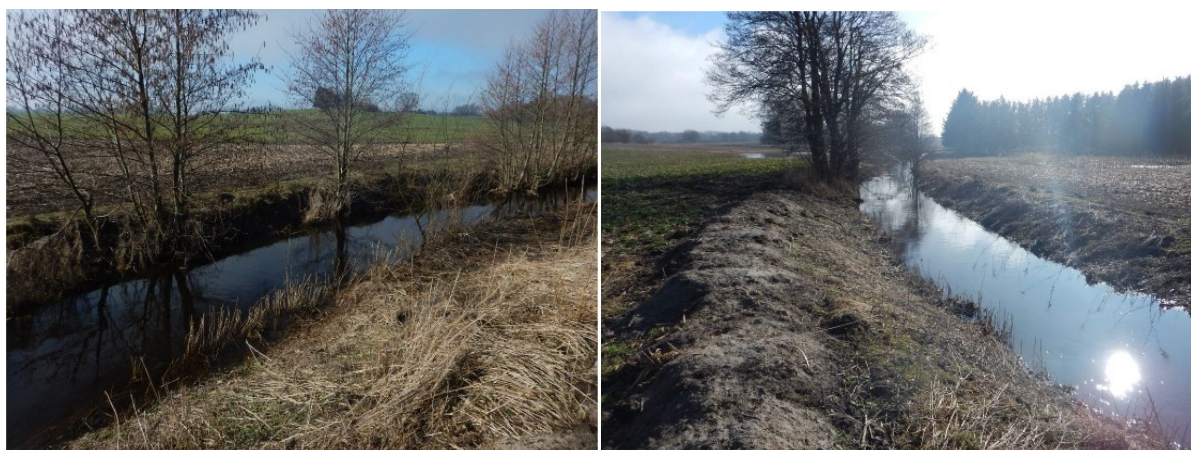
Figur 9. Torpe Kanal ved underboringen set i nedstrøms retning (venstre) og opstrøms retning (højre).
