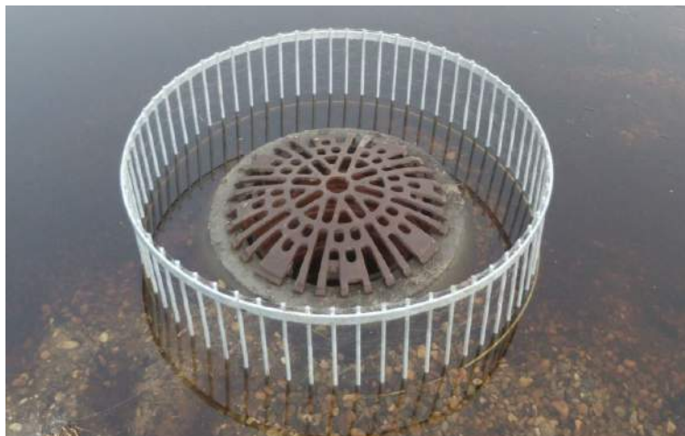
Figur 4-10 Eksempel på afløb med kuppelrist og "løvebur".
