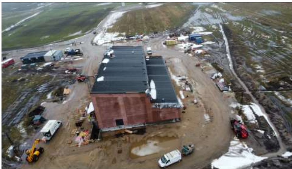
Figur 6. Fotos af byggepladsen ved Energinet transformatorstation marts 2024. Billedet er taget fra nord. Set fra nord vil volden skulle etableres foran bygningen.
