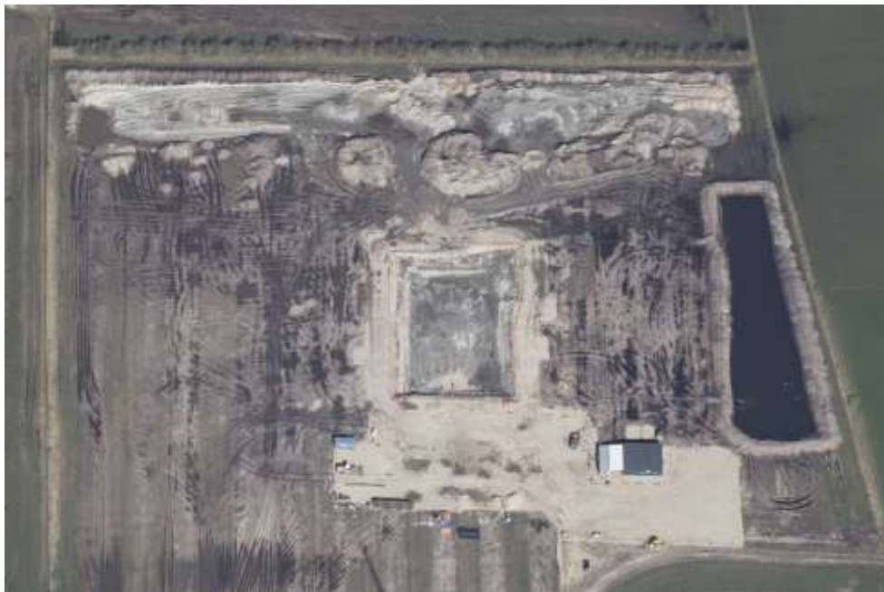
Figur 4. Luftfoto fra 3.4.2023 viser, at anlægsarbejdet på Energinets transformatorstation er begyndt. Der er udgravet til en kælder og overskudsjorden er placeret i bunker på stationens nordlige del.
