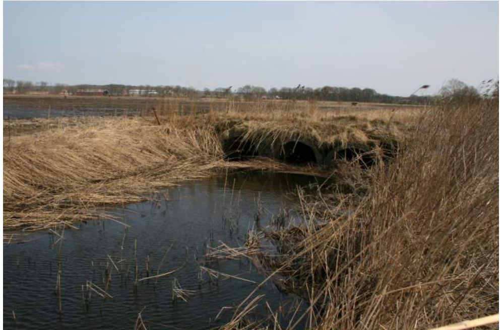
Figur 8 Overkørsel. Pumpelaget ses til venstre.
