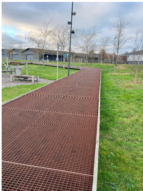
Figur 5 Eksempel på boardwalk med overflade af cor- tenstålriste. Foto: Lasse Filsø, Thisted kommune
