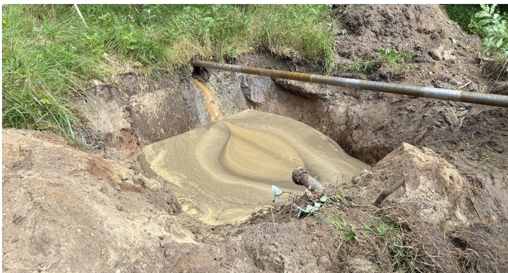
Figur 10 – Eksempel på en boregrube, hvor underboringen er igangsat.
