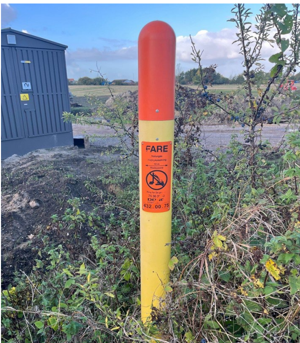
Figur 15 - Billede af mærkestander, der markerer gasledning
