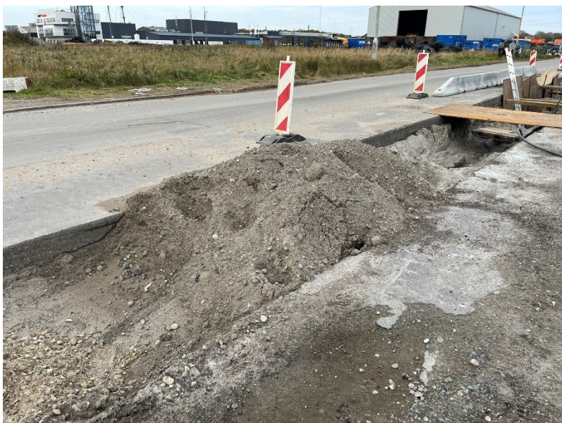
Figur 6 – viser ledningsgrav anlagt med begrænset arbejdsareal
