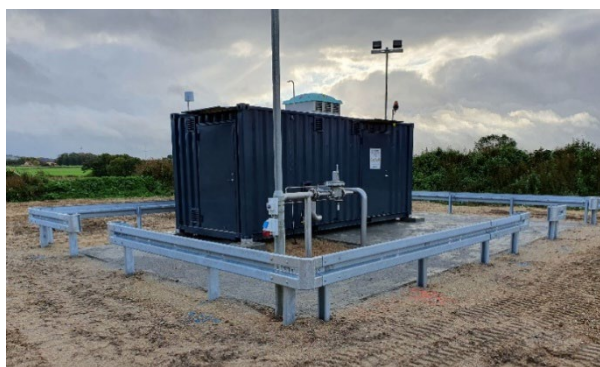
Figur 9- Foto som viser eksempel på en BMR- station
