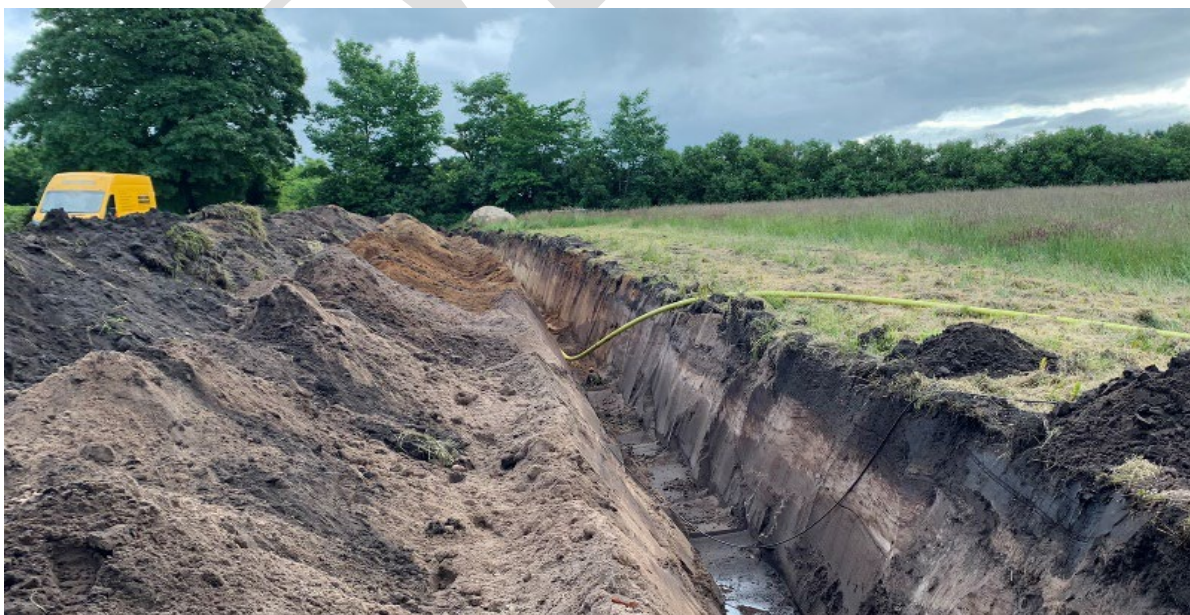
Figur 0 – Eksempel på anlæggelse af gasledning i åben ledningsgrav. Kilde: Evida
