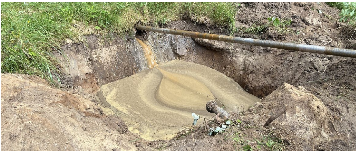
Figur 4. Eksempel på en boregrube med boremudder, hvor underboringen er igangsat. Kilde Evida.
