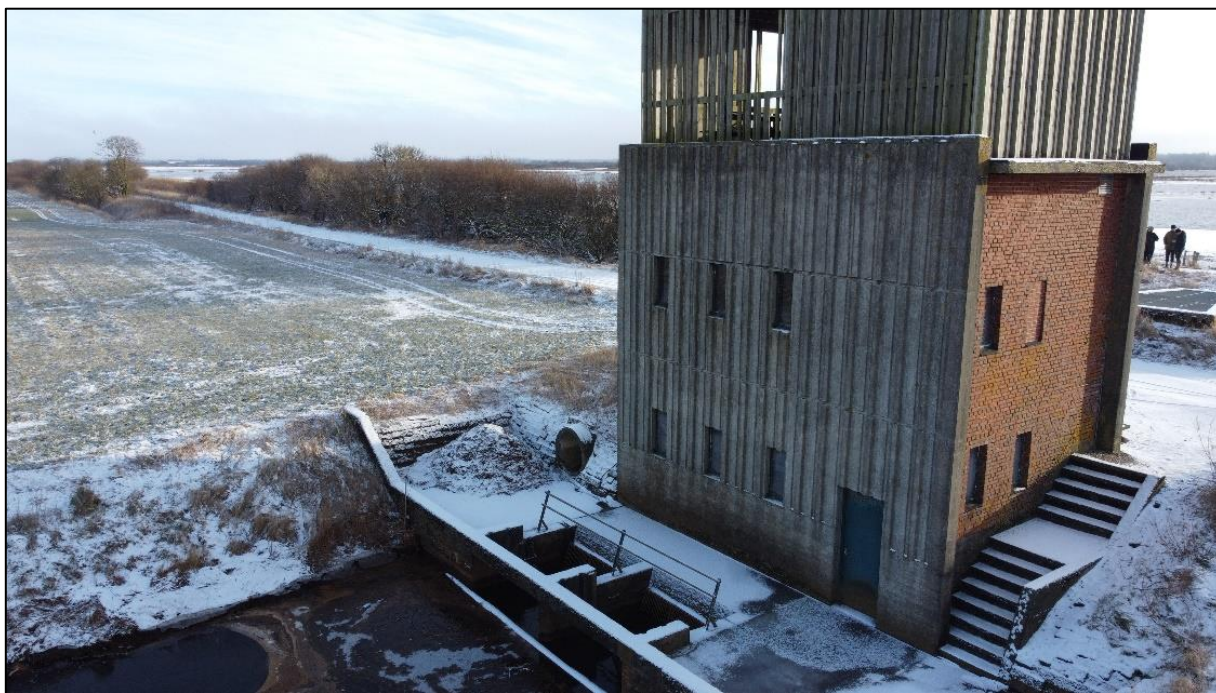
Figur 6-5 Billede af pumpehuset med udkigspost på toppen. Nederste etages vinduer og døre mures til og der fyldes op med jord. Betonværket der ses længst til højre i billedet, bliver ligeledes ikke synligt fremover.
