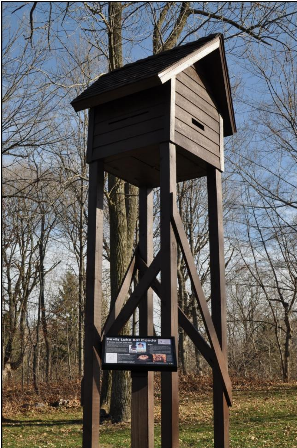
Figur 5. Mindre flagermusshelter monteret højt på pæle. Kilde: https://www.bcbats.ca/attachments/WDNR-BatCondo.pdf
