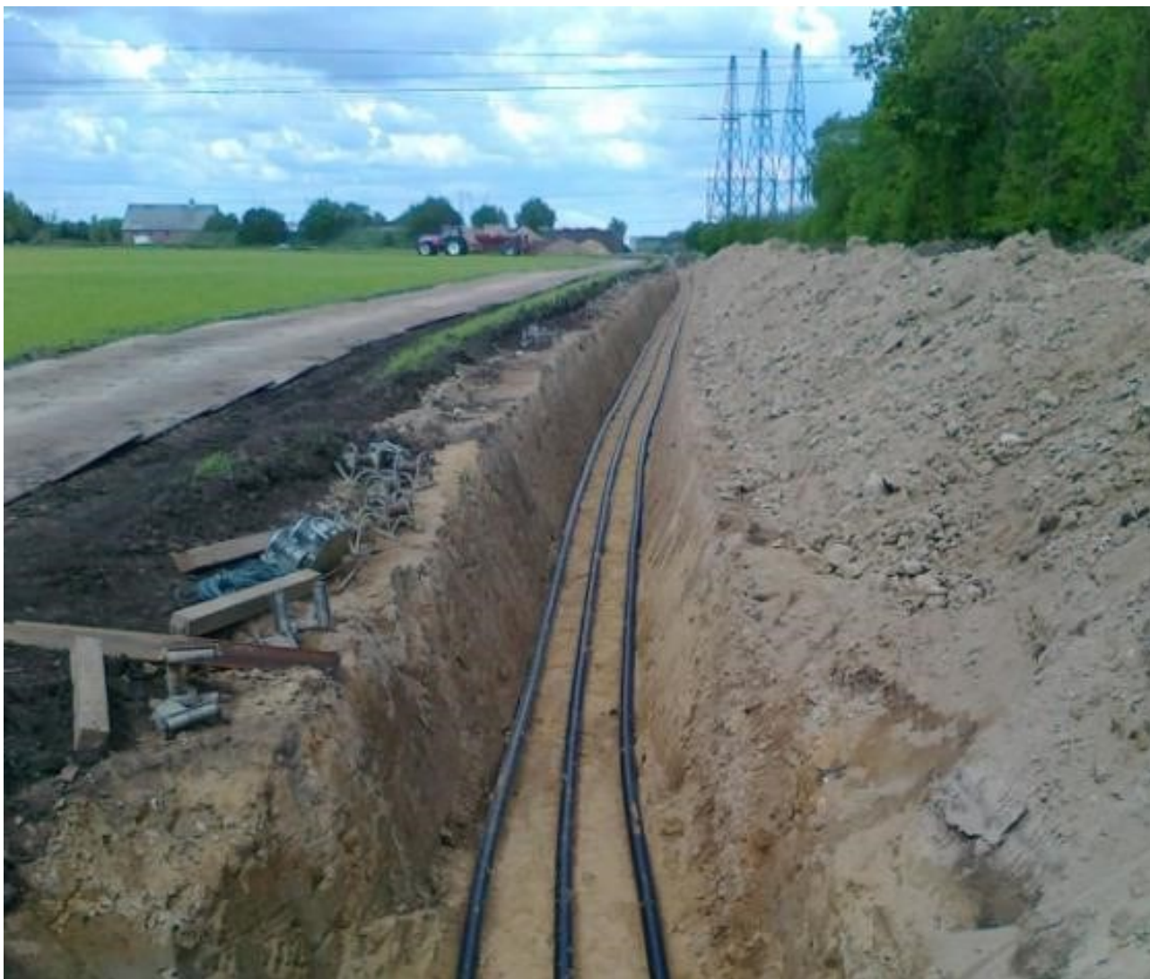
Figur 3.6 Kabelanlæg lagt ud i åben grav.
