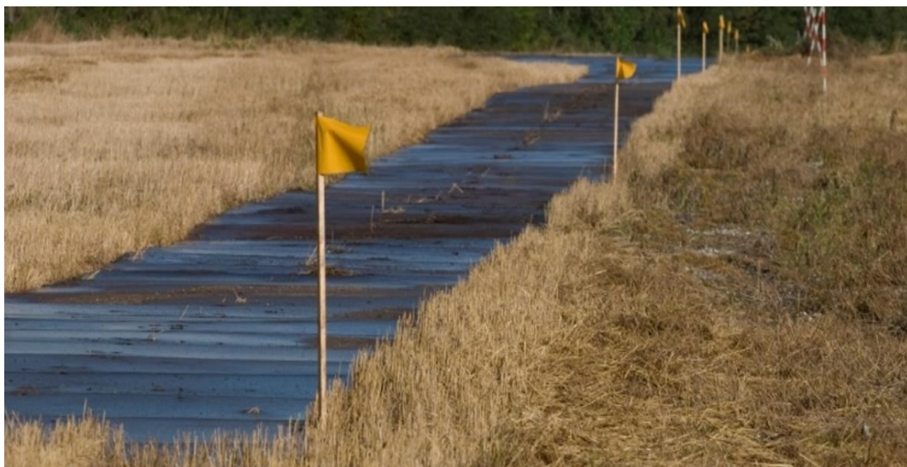
Figur 3.15 Adgangsvej med køreplader.
