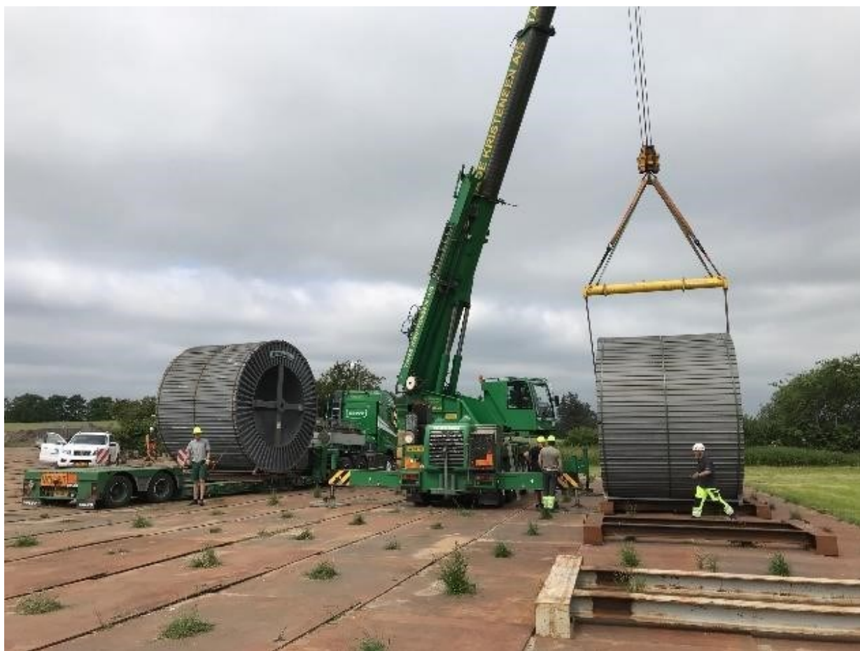
Figur 3.14 Håndtering af kabeltromler på tromleplads
