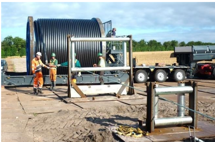
Figur 3.16 Kabeltromle på blokvogn
