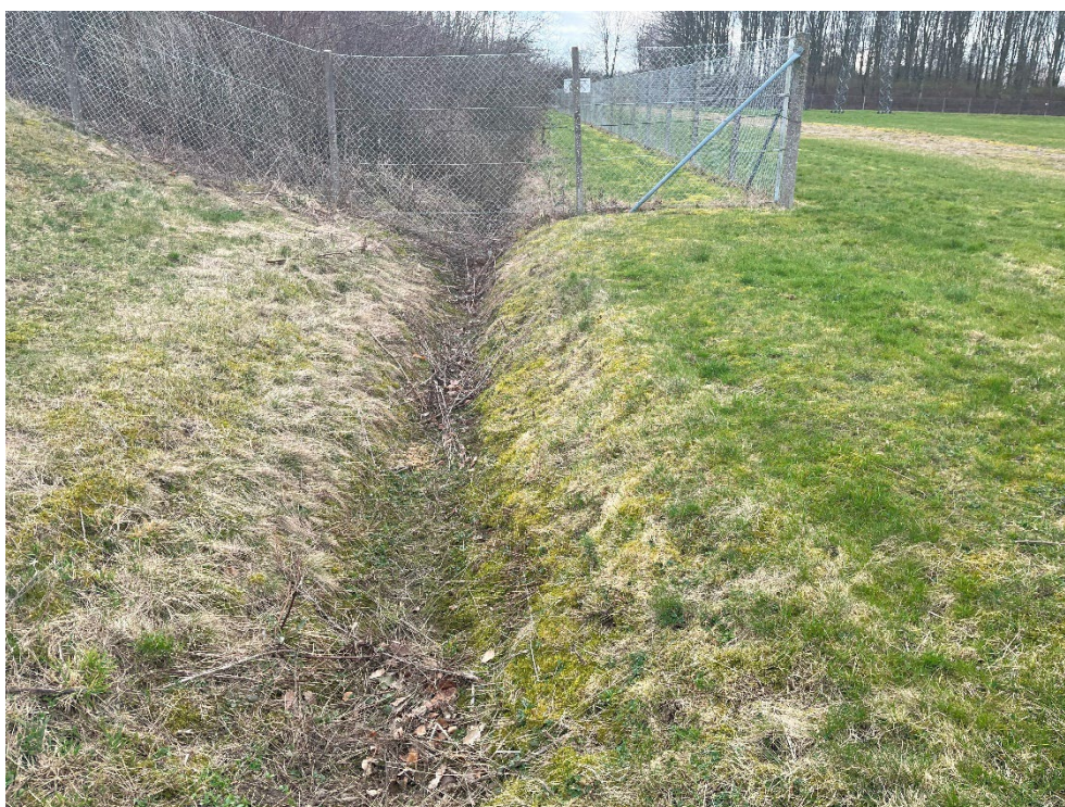
Figur 4-31 Den vestligste ende af TR09T afgrænses fra transformatorstationens område af en udtørret grøft (Foto: 18. marts 2024).
