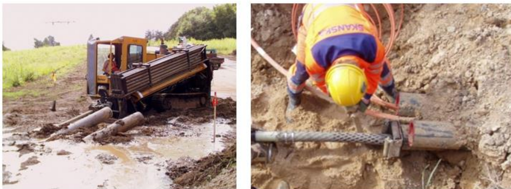
Billede 7. Underboringsmaskine og trækning af kabler igennem underboring.
