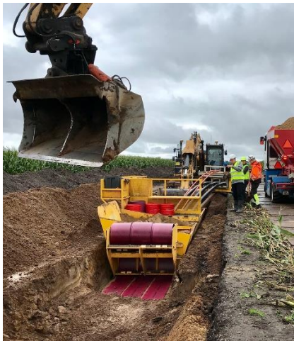
Billede 3. Nedlægning af 150 kV-kabler i flad forlægning ved hjælp af gravekasse.
