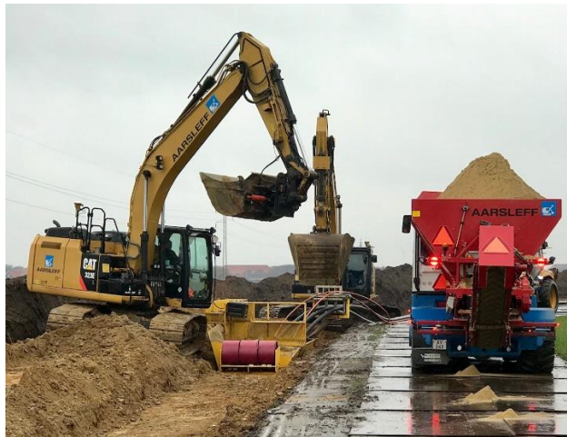
Billede 3. Nedlægning af 150 kV-kabler i flad forlægning ved hjælp af gravekasse.
