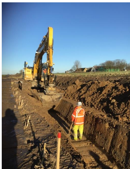
Billede 4. Opgravning af kabelrende til åben grav.
