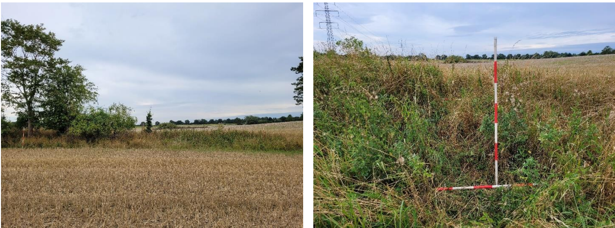
Figur 11 Fotos af det potentielle gennembrudssted. På fotoet til venstre ses diget fra nord, og landmålerstængerne er placeret 16 m fra hinanden. Til højre ses et nærbillede af diget, hvor de vandrette landmålerstænger angiver toppen og foden af diget.
