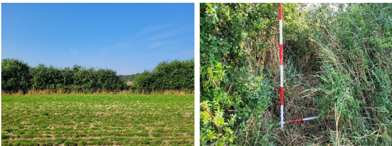
Figur 6 Fotos af det potentielle gennembrudssted. På fotoet til venstre ses diget med tilhørende hegn fra øst, og landmålerstængerne er placeret 16 m fra hinanden. Til højre ses et nærbillede af diget, hvor de vandrette landmålerstænger angiver toppen og foden af diget.
