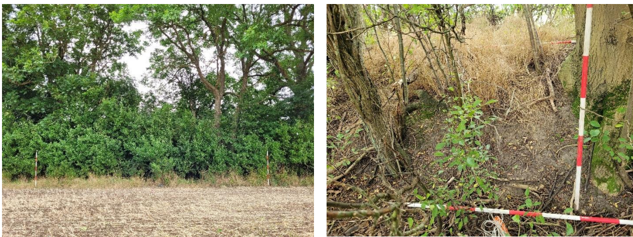
Figur 4 Fotos af det potentielle gennembrudssted. På fotoet til venstre ses diget med tilhørende hegn fra vest, og landmålerstængerne er placeret 10 m fra hinanden. Til højre ses et nærbillede af diget, hvor de vandrette landmålerstænger angiver toppen og foden af diget.
