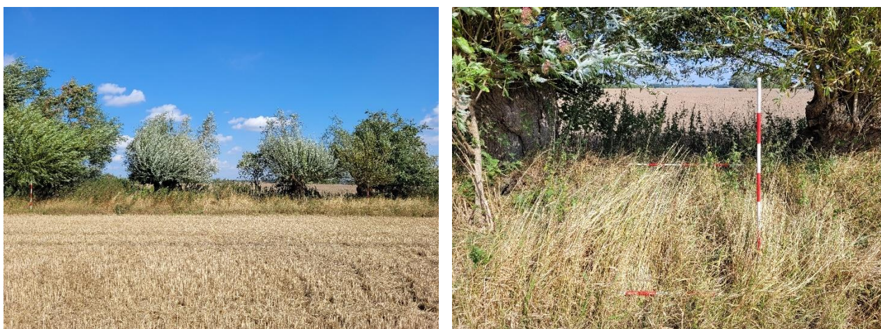
Figur 9 Fotos af det potentielle gennembrudssted. På fotoet til venstre ses diget med tilhørende hegn fra syd, og landmålerstængerne er placeret 16 m fra hinanden. Til højre ses et nærbillede af diget, hvor de vandrette landmålerstænger angiver toppen og foden af diget.
