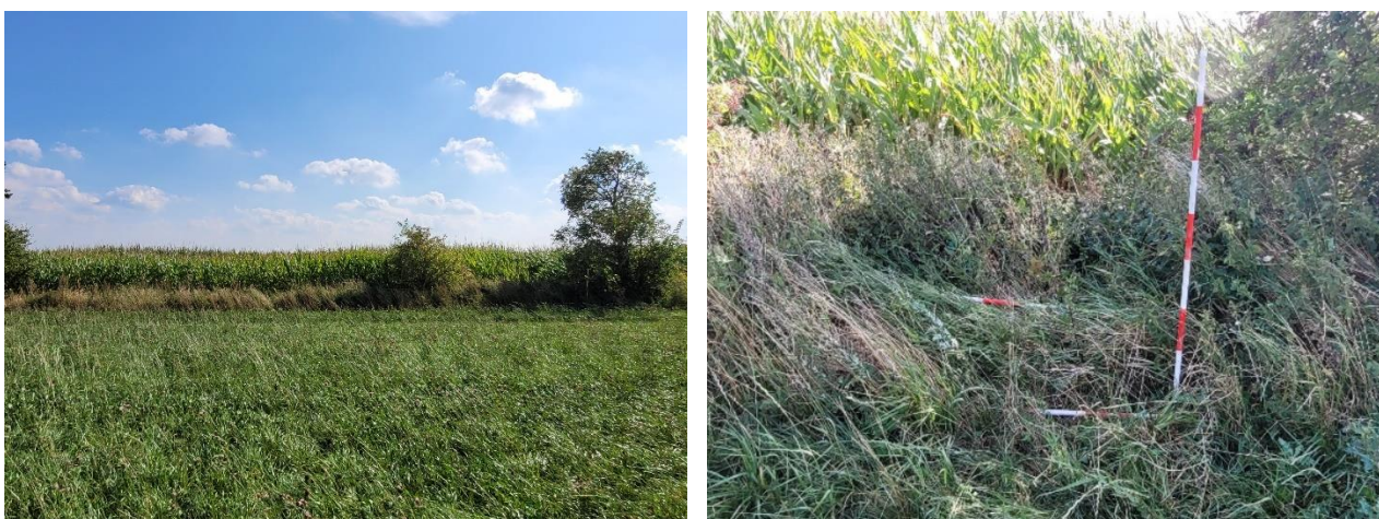
Figur 8 Fotos af det potentielle gennembrudssted. På fotoet til venstre ses diget fra vest, og landmålerstængerne er placeret 16 m fra hinanden. Til højre ses et nærbillede af diget, hvor de vandrette landmålerstænger angiver toppen og foden af diget.
