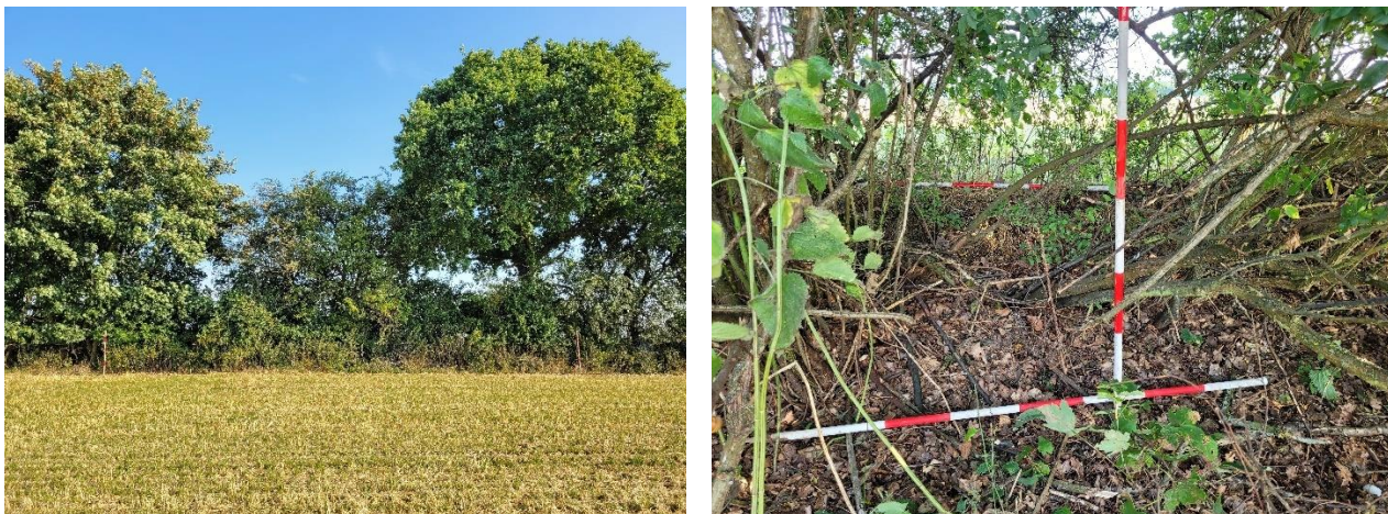
Figur 5 Fotos af det potentielle gennembrudssted. På fotoet til venstre ses diget med tilhørende hegn fra syd, og landmålerstængerne er placeret 16 m fra hinanden. Til højre ses et nærbillede af diget, hvor de vandrette landmålerstænger angiver toppen og foden af diget.
