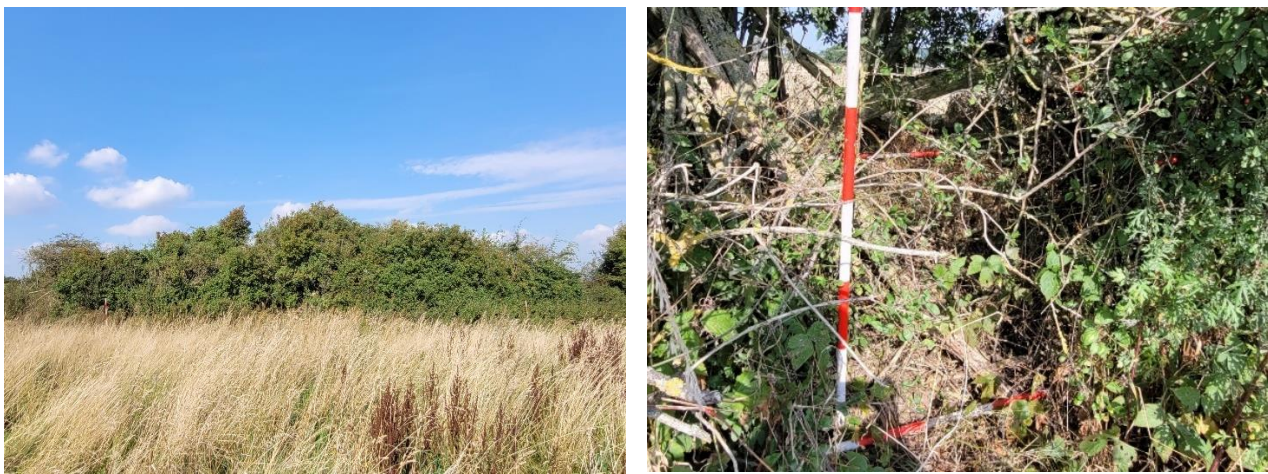
Figur 7 Fotos af det potentielle gennembrudssted. På fotoet til venstre ses diget med tilhørende hegn fra øst, og landmålerstængerne er placeret 16 m fra hinanden. Til højre ses et nærbillede af diget, hvor de vandrette landmålerstænger angiver toppen og foden af diget.
