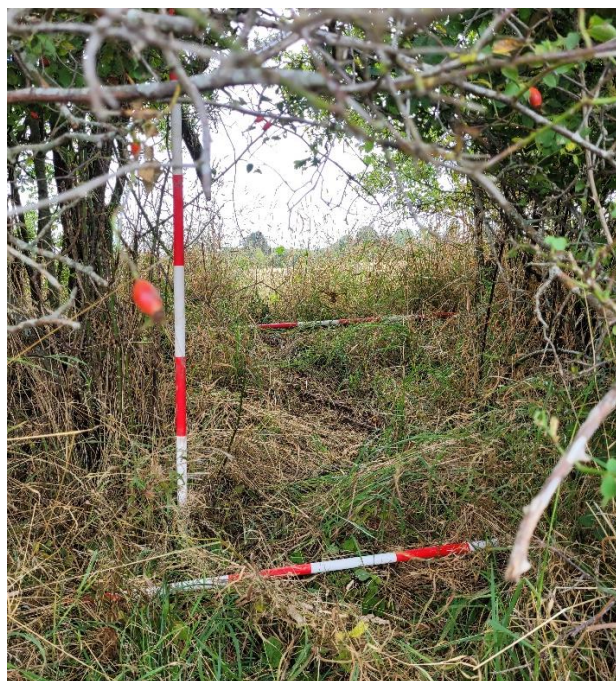
Figur 2 Fotos af det potentielle gennembrudssted. På fotoet til venstre ses diget med tilhørende hegn fra øst, og landmålerstængerne er placeret 10 m fra hinanden. Til højre ses et nærbillede af diget, hvor de vandrette landmålerstænger angiver toppen og foden af diget.
