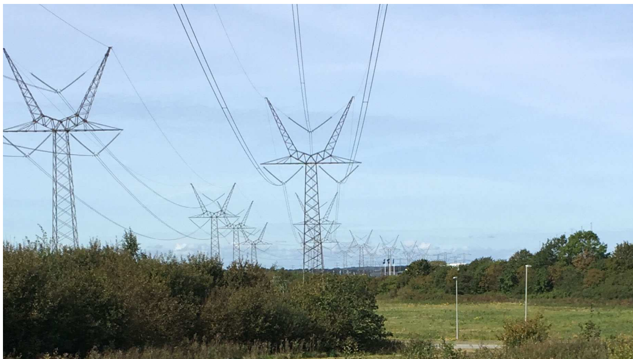
Figur 8: I midten af billedet mast nr. 326 tæt ved Henneberg Ladegaard. Masten er formet som et Y – deraf navnet Y-mast. Masten skiftes med en tilsvarende ny Y-mast. Masterækken til venstre er den sydlige luftledning, som ikke er omfattet af projektet.
