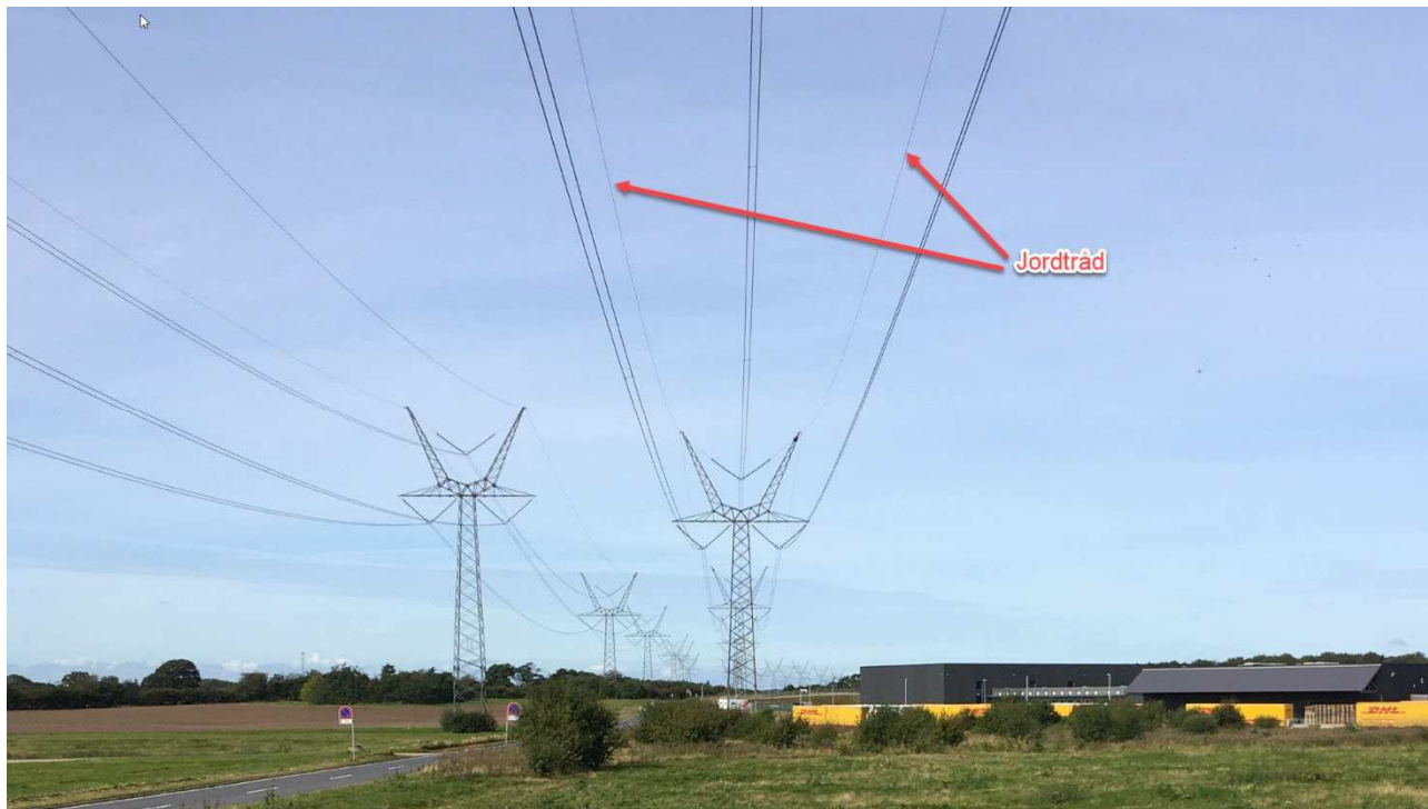
Figur 3: I midten af billedet mast nr. 328 tæt ved Henneberg Ladegaard. Jordtråden i toppen af masten er markeret med røde pile. Masterækken til venstre er den sydlige luftledning, som ikke er omfattet af projektet.
