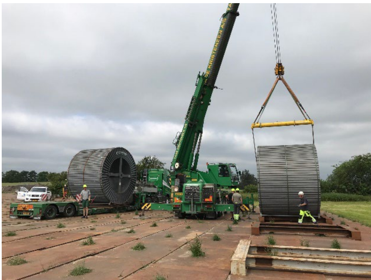
Figur 3-6. Håndtering af kabeltromler på tromleplads.
