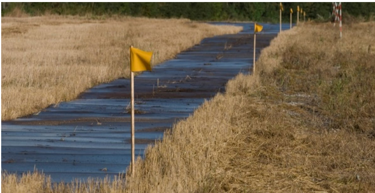
Figur 3-9. adgangsvej med køreplader.
