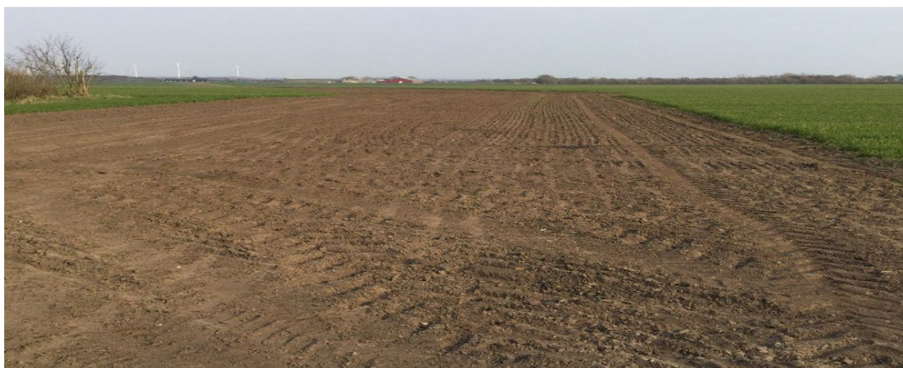
Figur 3-4. Eksempelfoto på udjævnet anlægsbælte.
