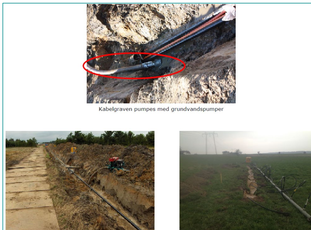
Figur 3-5. Forskellige metoder til at holde kabelgraven tør. På billedet til venstre etableres drænrør, til højre etableres sugespidsanlæg
