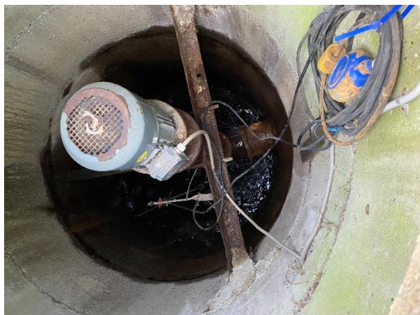
Figur 2.7 Pumpebrønd inkl. pumpe i Lindum Enge.
