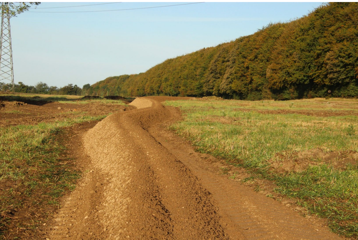
En ny skovsti hvor grus endnu ikke er komprimeret med tromle. Rugballegård Skov, Horsens, forår 2022.
