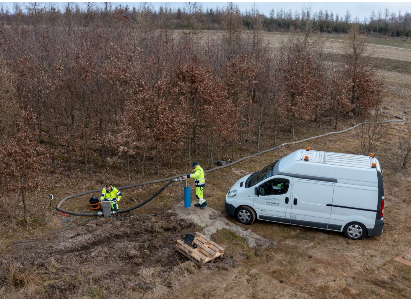
Skanderborg Forsyning prøvpumper en af de nye borer i Anebjerg Skov, efterår 2022. Foto: Skanderborg Forsyning
