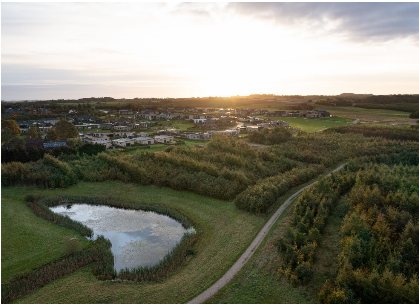
Regnvandsbassin i Anebjerg Skov der modtager regnvand fra boligområdet, Agerhønebakken. Billedet er taget i oktober 2022, ti år efter etablering af boligområdet og denne del af skoven. Foto Kim Aaen
