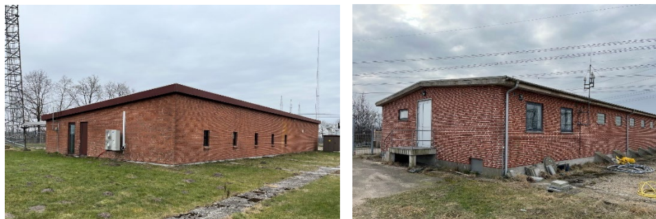
Figur 3-8 Fotos af de to manøvrebygninger, der nedrives på det eksisterende stationsareal.
