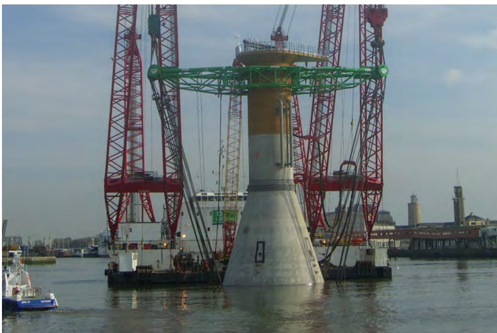
Figur 18 Koniskt gravitationsfundament (källa: COWI).
