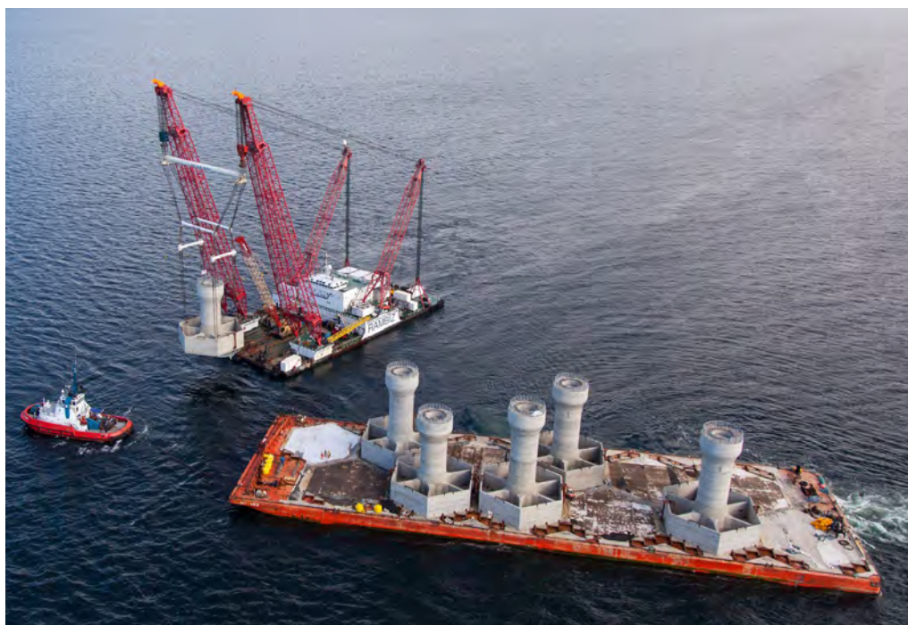
Figur 19: Gravitationsfundament med kassunutformning (källa: COWI).
