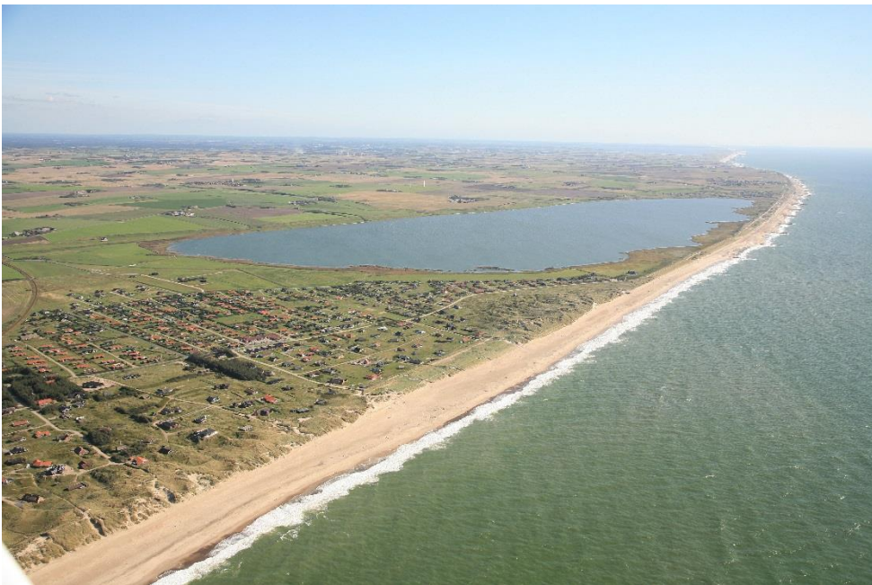
Figur 3C-8. Billede set fra Nord mod syd, dækkende størstedelen af Fællesaftalestrækningen, Vejlby Klit - Ferring Sø
